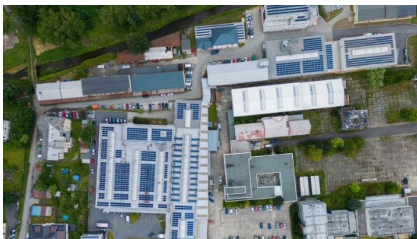
Obrázek 3.6: Letecký snímek části výrobního areálu FENIX s jednotlivými střešními fotovoltaickými elektrárnami.
