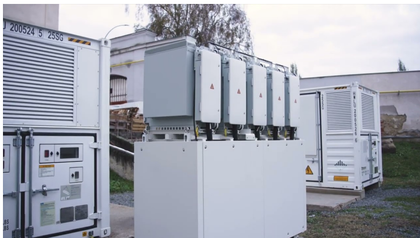
Obrázek 3.10: Měníče na jednom z transformátorů, v pozadí se nachází kontejnerová úložiště. [91]
