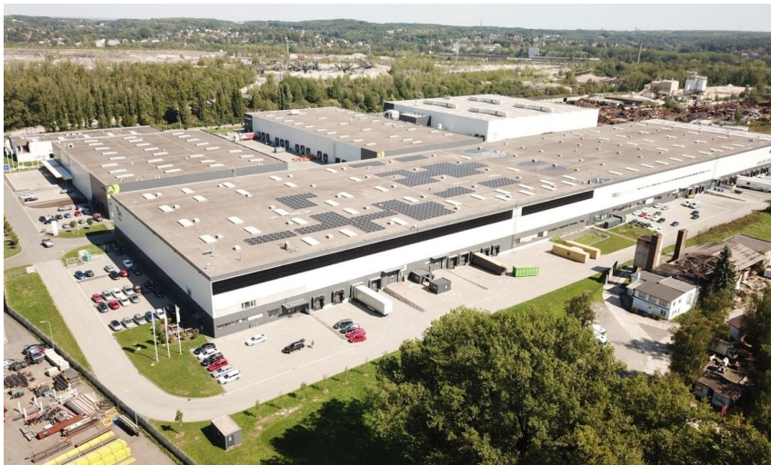
Obrázek 3.1: Vzdušný pohled na výslednou instalaci fotovoltaických panelů. [78]
