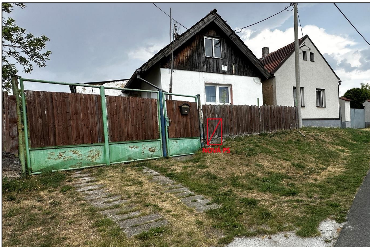
Obr. 7-9 Odběrné místo č. p. 69; zdroj: autor.
