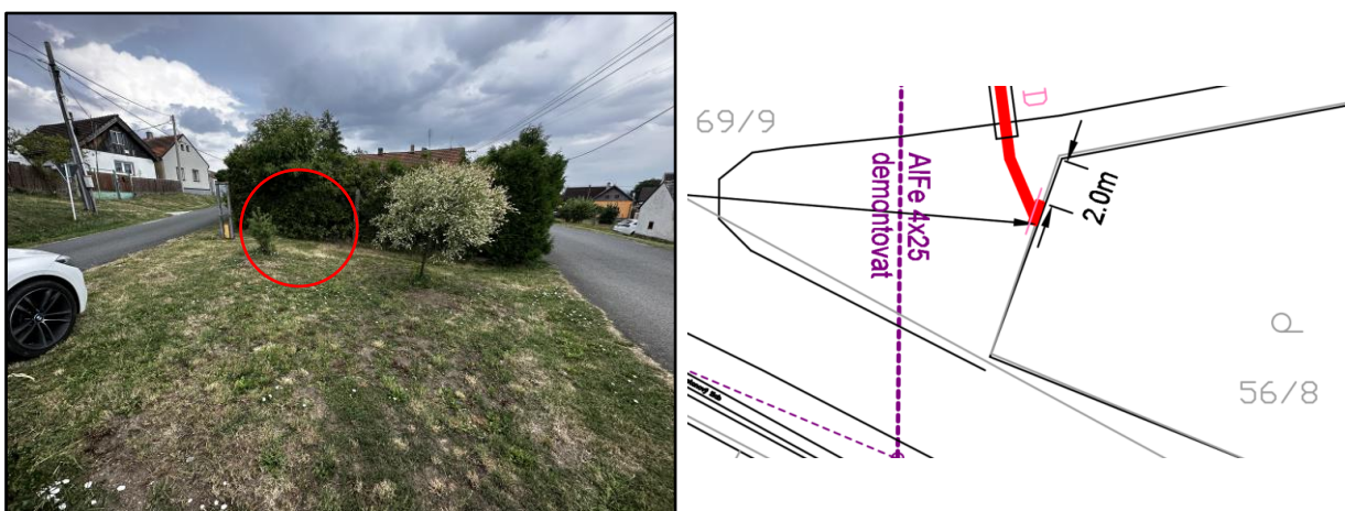
Obr. 7-4 Umístění nové rozpojovací skříně R8; na fotografii poloha vyznačena červeným kruhem; zdroj: autor.
