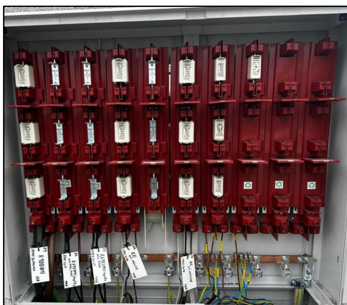
Obr. 1-5 Vnitřní uspořádání rozpojovací skříňe (vlevo typ SR522/NKW2 a vpravo typ SD022/NKW2). Zdroj: autor.
