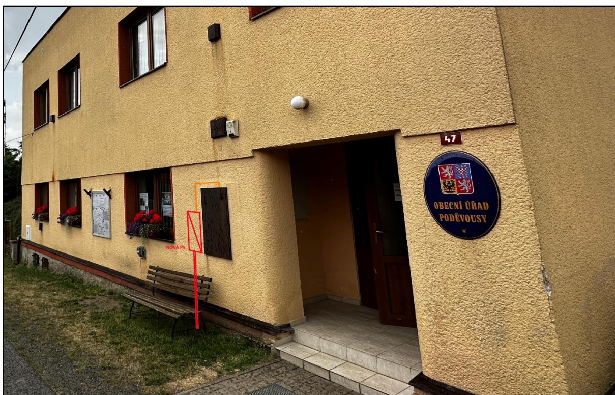
Obr. 7-7 Odběrné místo č. p. 47; zdroj: autor.
