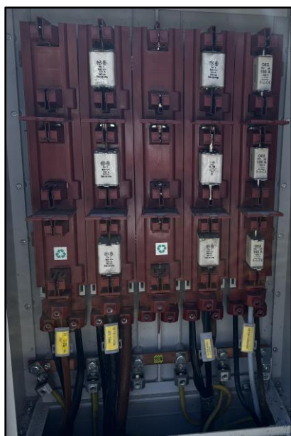
Obr. 1-5 Vnitřní uspořádání rozpojovací skříňe (vlevo typ SR522/NKW2 a vpravo typ SD022/NKW2). Zdroj: autor.
