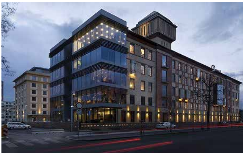
Rekonštrukcia Parných mlynov – Vít Máslo, David Chisholm
