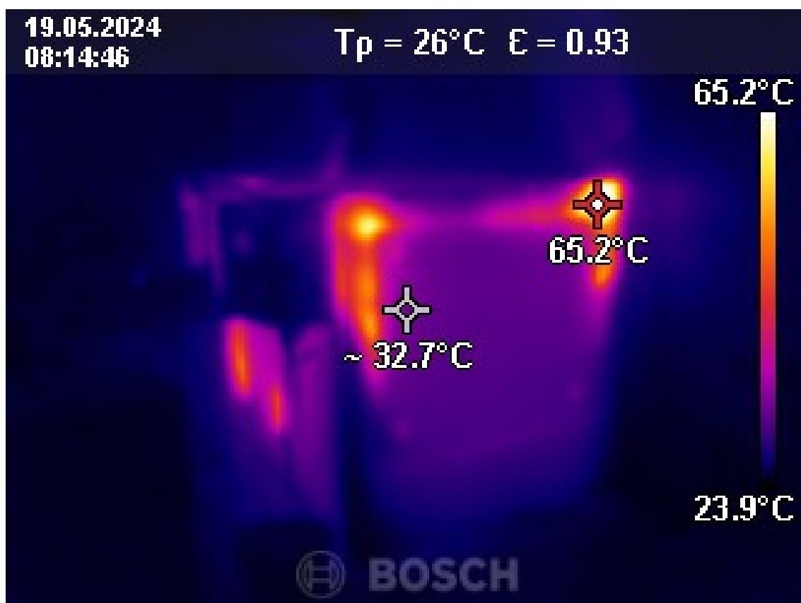
Obr. 10.10: Pohled na pec termokamerou
