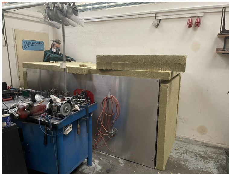
Obr. 5.5: Pokládání izolace
