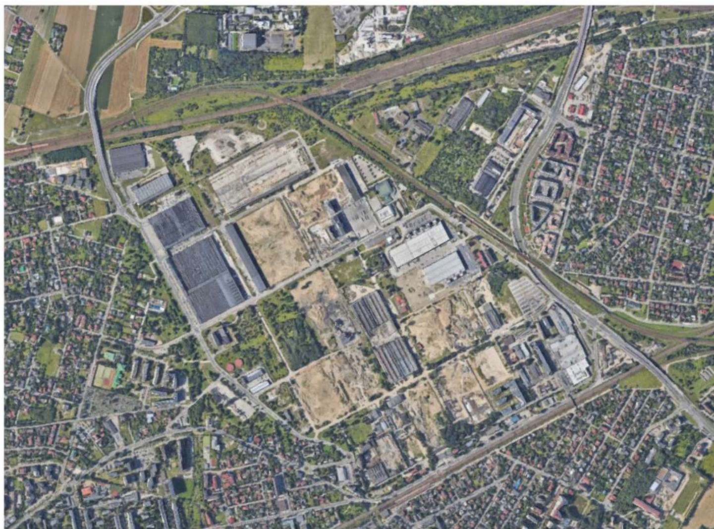
P1 Postupná transformácia brownfieldu Szamoty, Varšava (PL) (Zdroj: https://www.google.com/maps )
