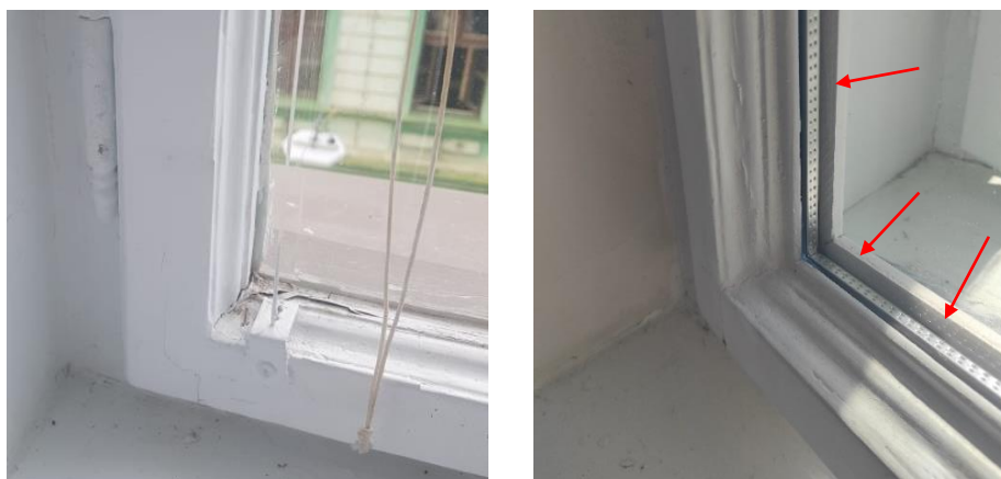
Obr. 82 - Rám okna před opravě (vlevo) a po úpravě vpravo. Rám je podepřen přidáním dřeva na jeho vnější povrch [autor]
