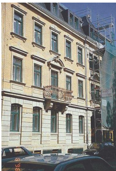
Obr. 33 - Uliční fasáda zkoumané budovy v Drážďanech [41]
