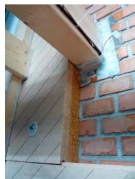
Obr. 39 - Těsnicí páska připevněná k dřevěnému nosníku (systém S1) [44]
