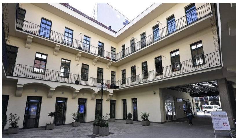
Obr. 4 – Pohled na pavlačový dům ze dvora, Praha [11]
