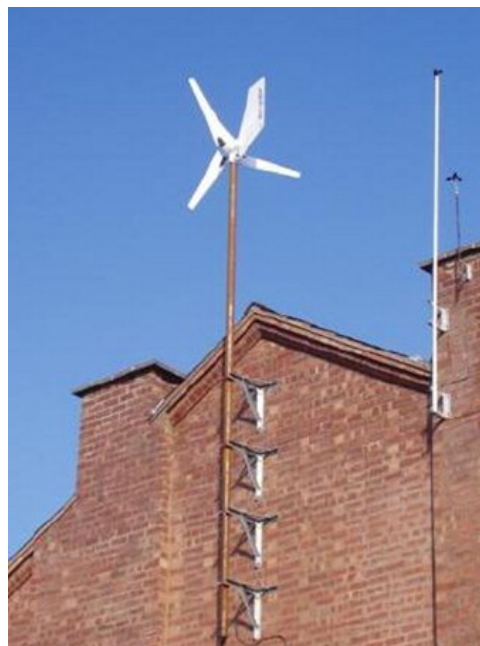
Obr.8.2 Příklad nástěnné instalace [18]
