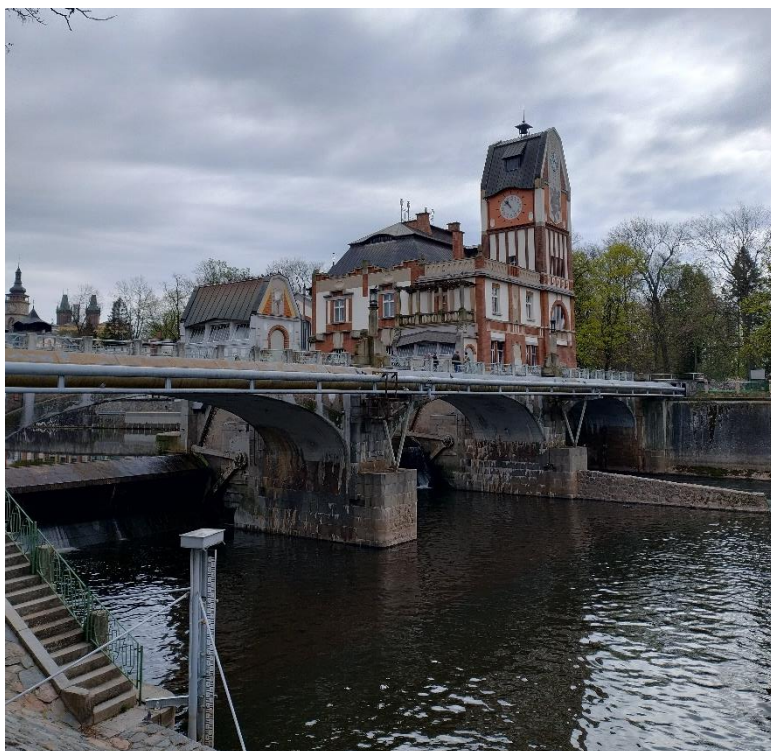
Obrázek č.20– Vodní elektrárna „Hučák“
