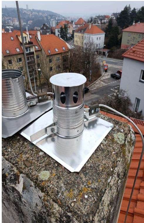
OBRÁZEK 10: KONTROLA PROVEDENÉ PRÁCE NA KOMÍNĚ (ZDROJ: ŠKOLA JAROV (2023))
