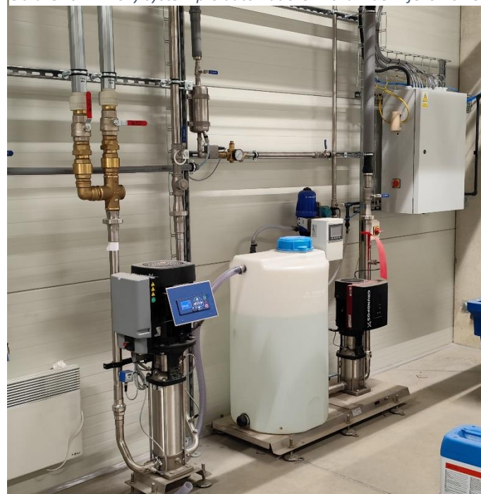
Obrázek č. 27 Nový systém pro automatické míchání dezinfekční směsi
