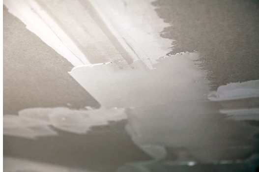
Obrázek 11:Nanesení druhé vrstvy tmelu[12]
