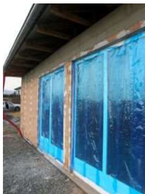
Obrázek 1: Zakrytí oken folií[11]
