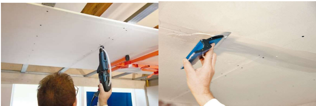
Obrázek 10:Připevnění desek[12]
