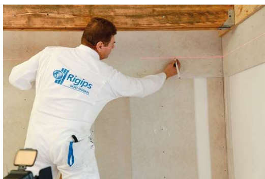
Obrázek 6: Vyznačení polohy SDK podhledu[12]
