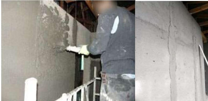
Obrázek 2: Nanesení jádrové omítky[11]
