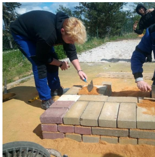
OBRÁZEK 20 - VAZBA ROHU NA JEDEN A PŮL CIHLY, NÁCVIK 2
