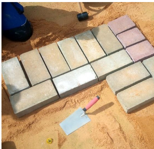
OBRÁZEK 19 - VAZBA ROHU NA JEDEN A PŮL CIHLY, NÁCVIK 1
