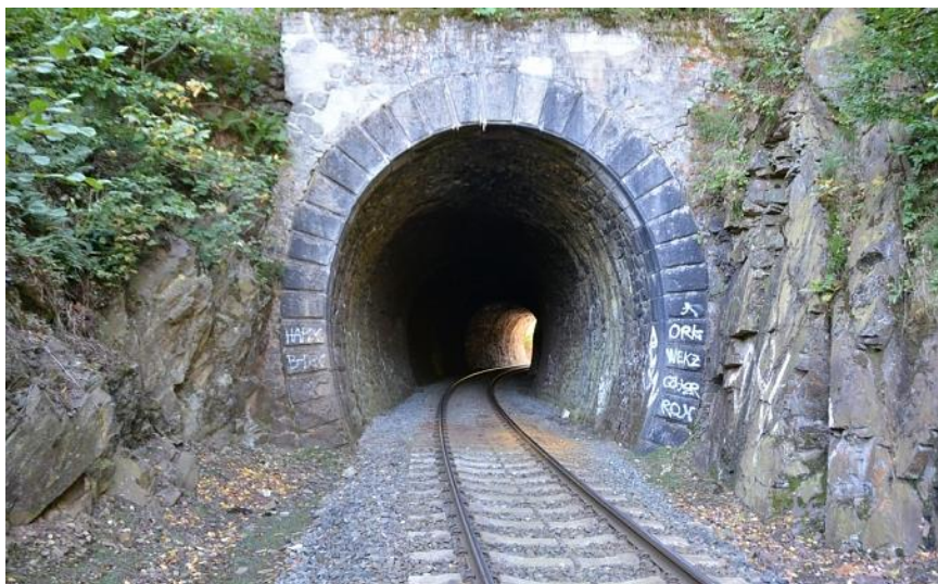
obr. č. 10 – tunel nacházející se mezi zastávkami Bojov a Klíнец [18]
