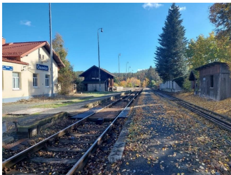
obr. č. 29 – současný stav ŽST Čisovice, zdroj: autor
