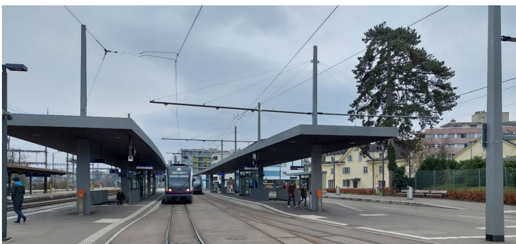
obr. č. 58 – počáteční stanice Dietikon, uprostřed lehký kolejový systém, vpravo tramvaj, vlevo konvenční železnice, zdroj: autor
