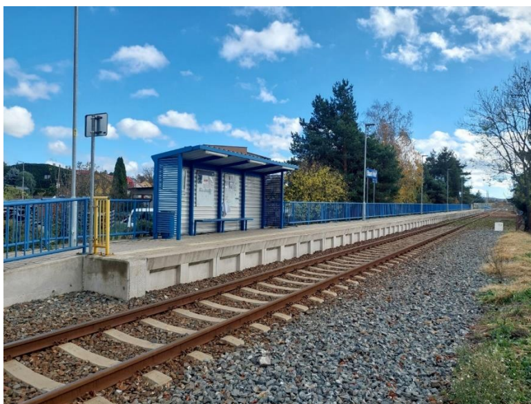
obr. č. 15 – současný stav železniční zast. Stará Huť, zdroj: autor
