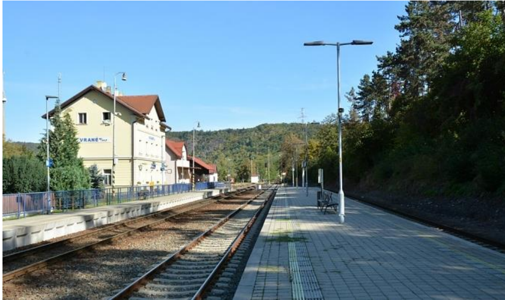
obr. č. 43 – současný stav ŽST Vrané nad Vltavou [25]
