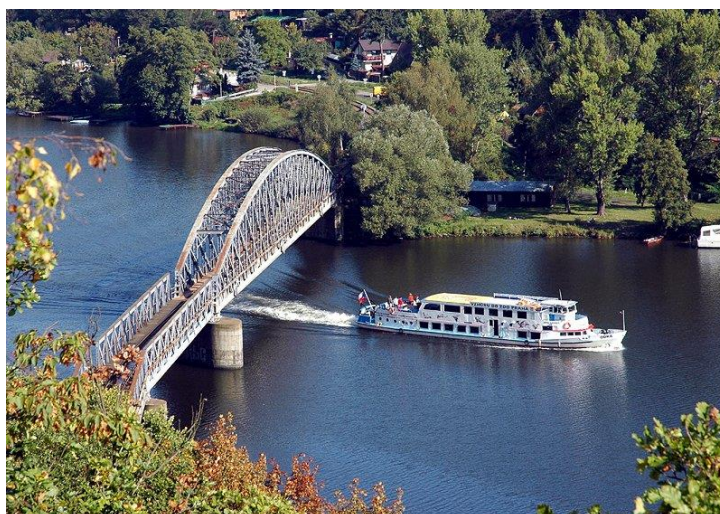
obr. č. 9 – železniční ocelový most v mezistaničním úseku Měchenice – Vrané nad Vltavou [17]
