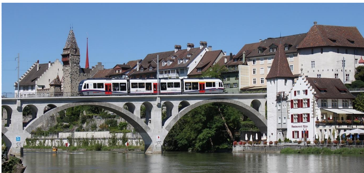
obr. č. 60 – železniční most přes řeku Reuss spojující části města Bremgarten [54]
