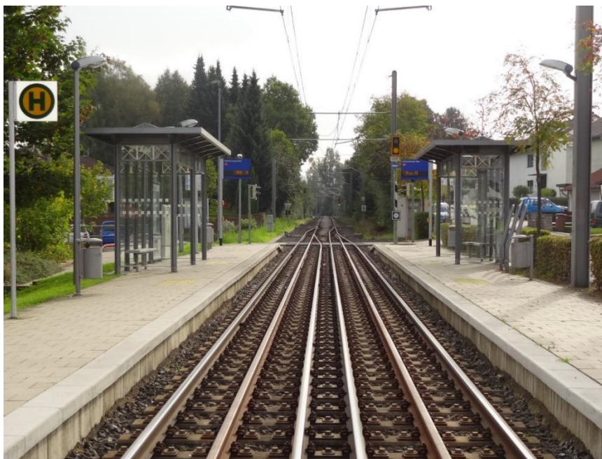
obr. č. 54 – kolejová splítka v zastávce Niederkaufungen Mitte [51]
