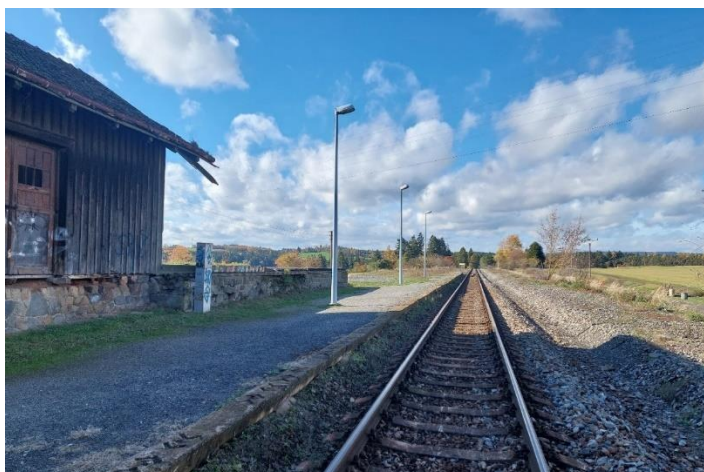
obr. č. 19 – pohled na současný stav zast. Malá Hraštice, vpravo si lze povšimnout čerstvě snesené koleje, zdroj: autor
