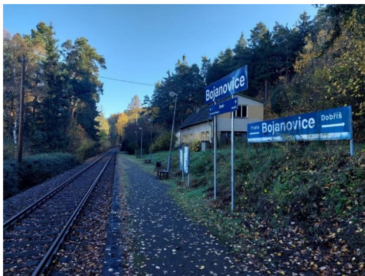
obr. č. 31 – současný stav zast. Bojanovice, zdroj: autor
