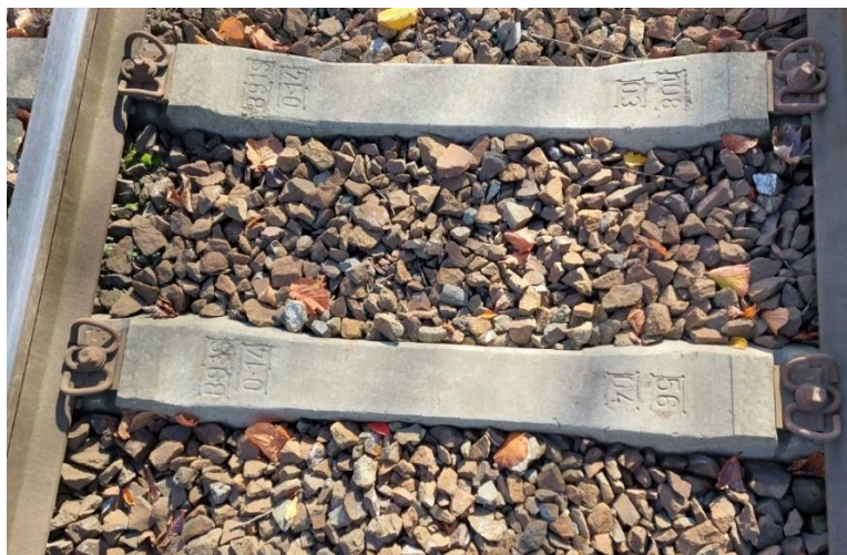
obr. č. 8 – ukázka konstrukce žel. svršku nedaleko zastávky Rymaně, zdroj: autor
