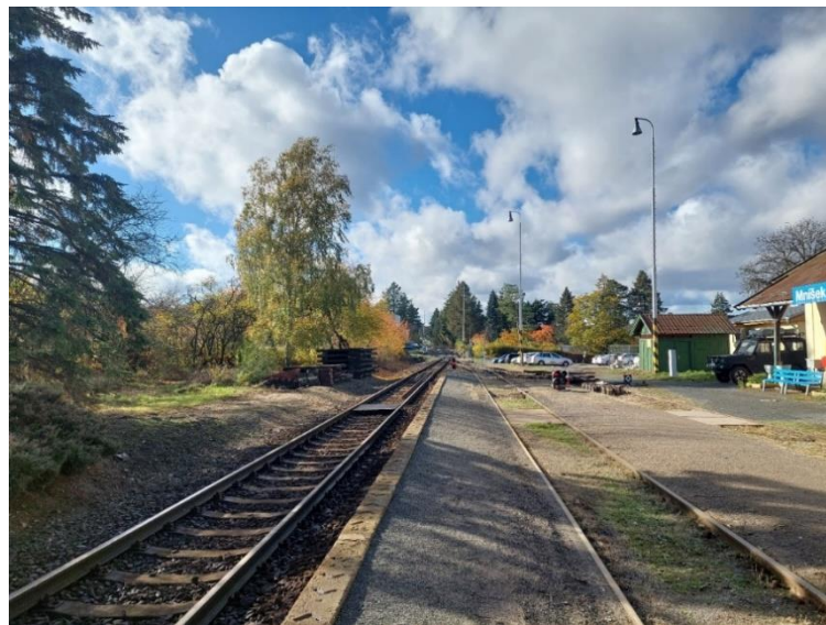
obr. č. 24 – současný stav ŽST Mníšek pod Brdy, zdroj: autor
