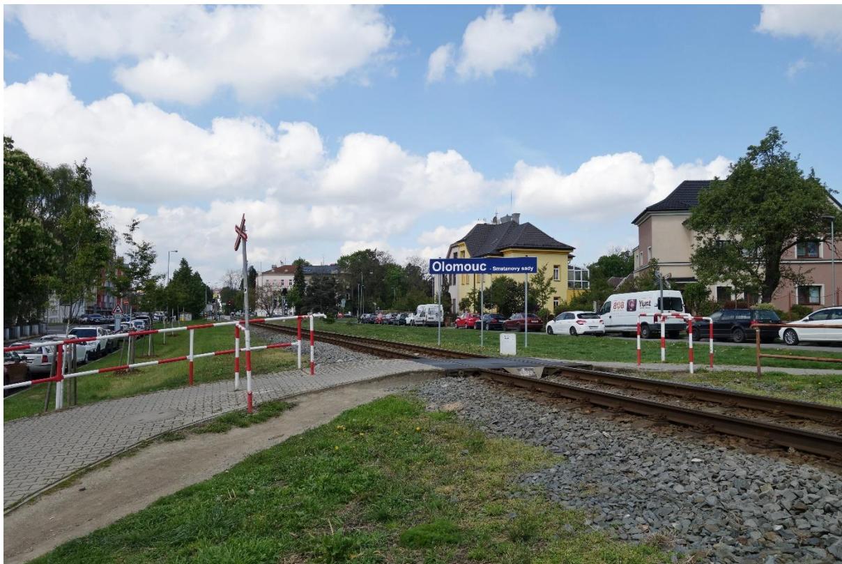
Obrázek 7: Železniční přečhod P7605 osazený meandrovým zábradlím (foto autor, 2024)
