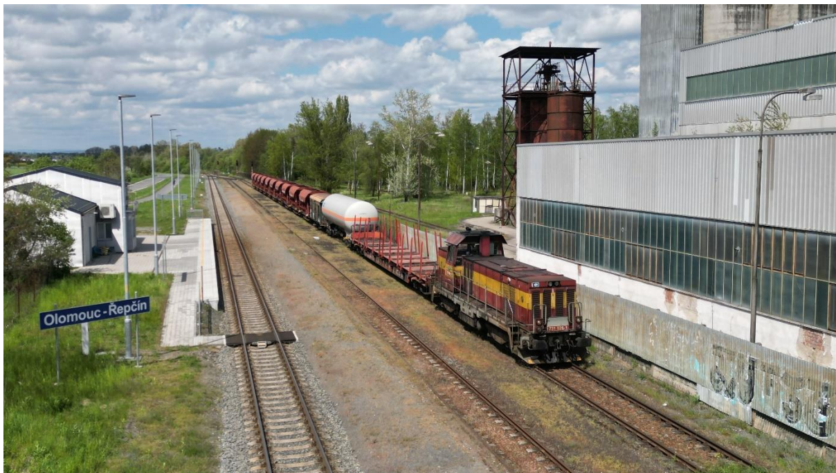
Obrázek 17: Kolejiště ŽST Olomouc-Řepčín v prostoru nástupišť, manipulační vlak právě obsloužil vlečku (foto Jan Navara, 2023)
