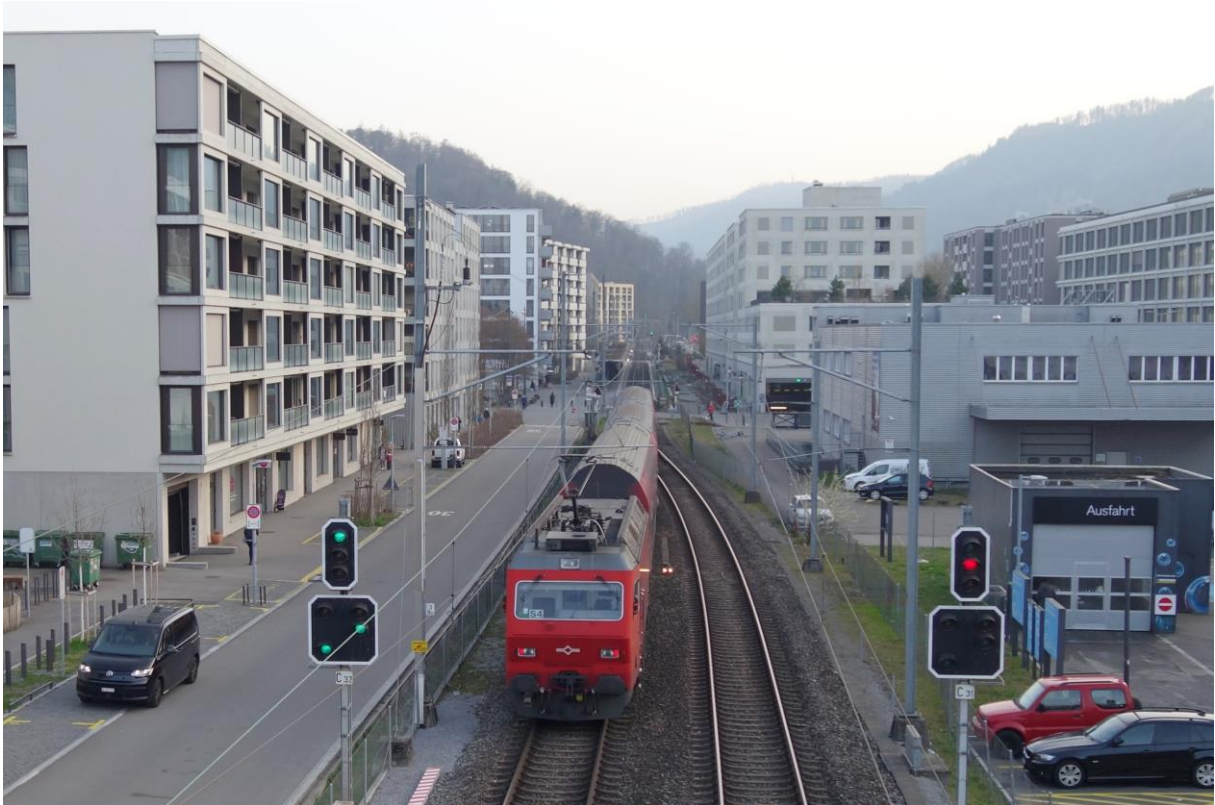
Obrázek 23: Výhybna Zürich-Manegg s nástupištěm v záhlaví (foto autor, 2024)
