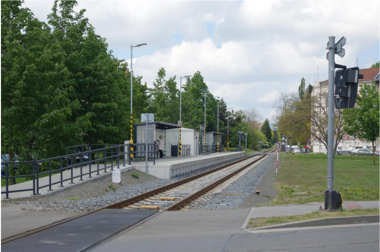
Obrázek 11: Železniční zastávka Olomouc-Smetanovy sady (foto autor, 2024)
