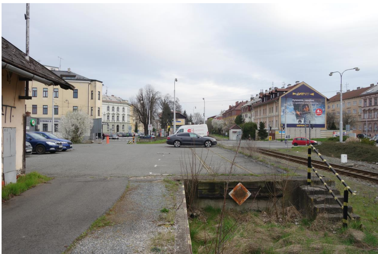
Obrázek 13: Rampa pro překládku tramvajů – Olomouc město (foto autor, 2024)
