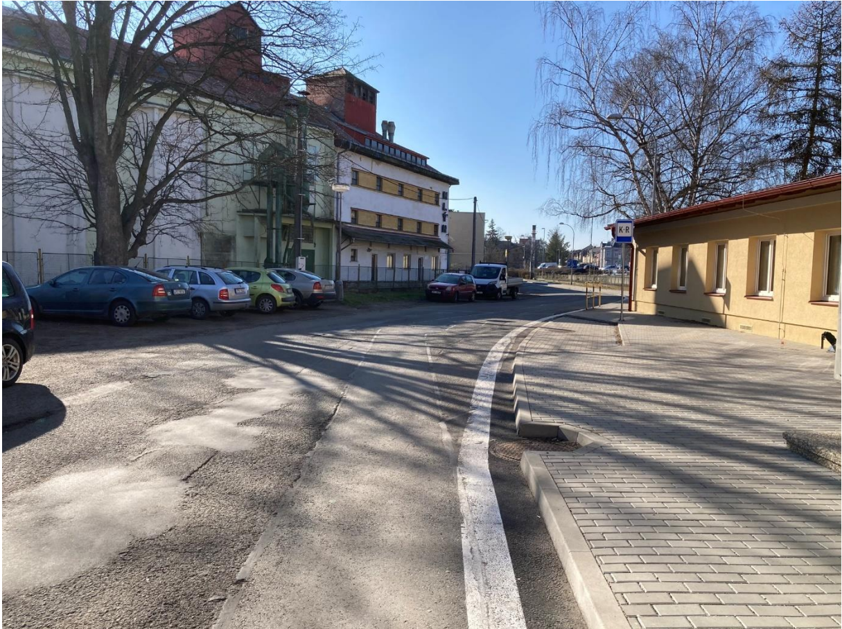
Obrázek 20: Stávající stav přednádražního prostoru v žst. Tachov; autor dne 9.3.2024.
