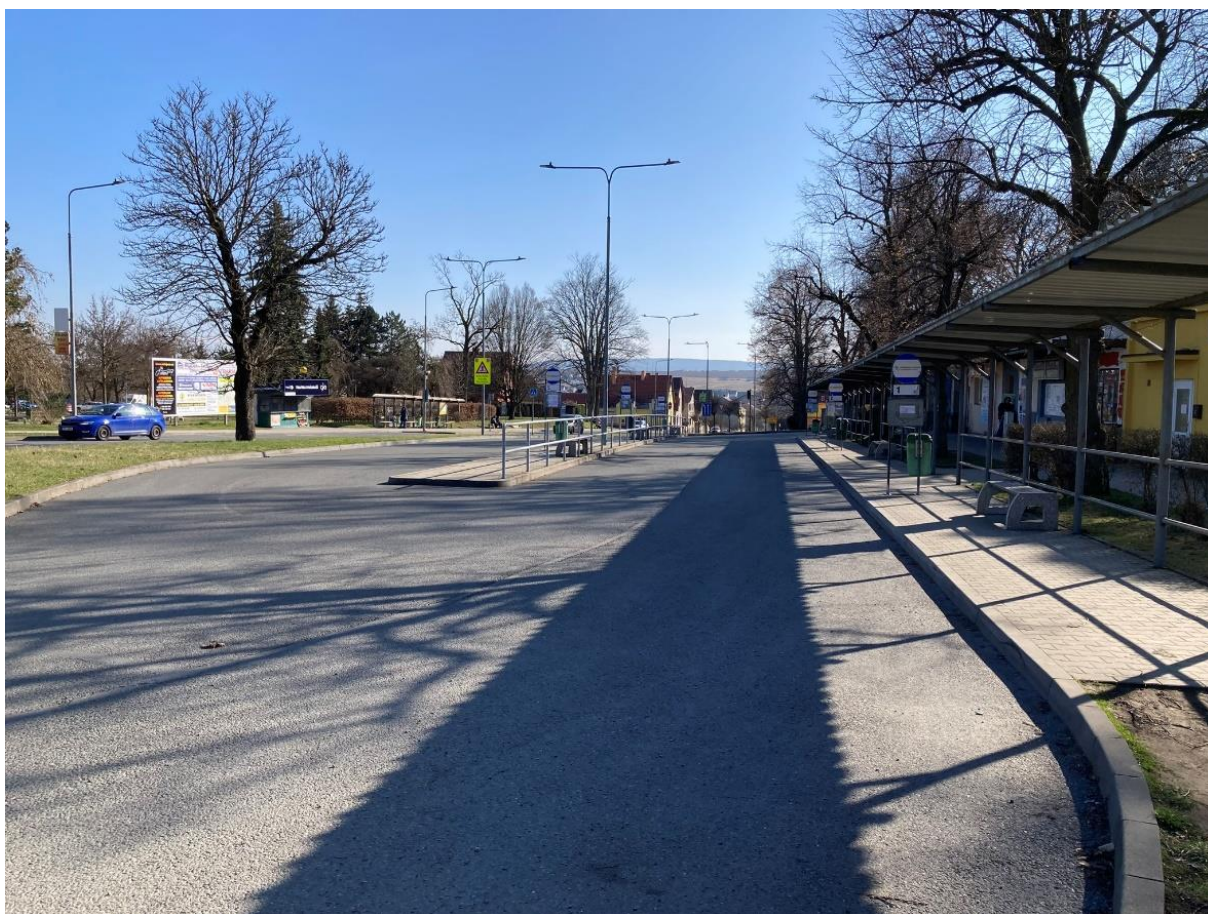
Obrázek 16: Stávající stav stanovišť 1-7 autobusového nádraží Tachov; autor dne 9.3.2024.
