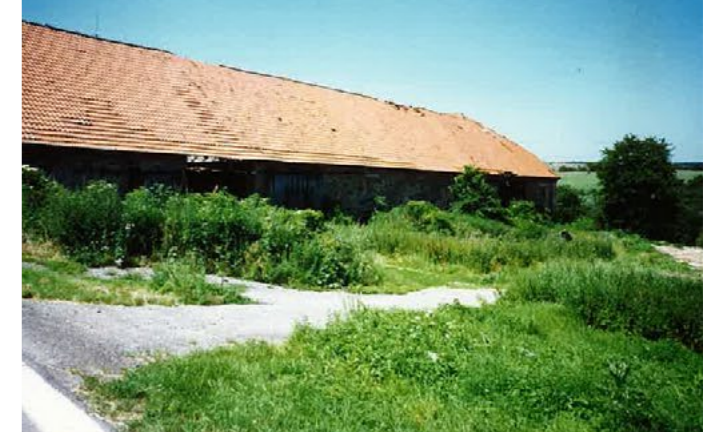
Severní pohled na stodolu (objekt D) r. 1990
