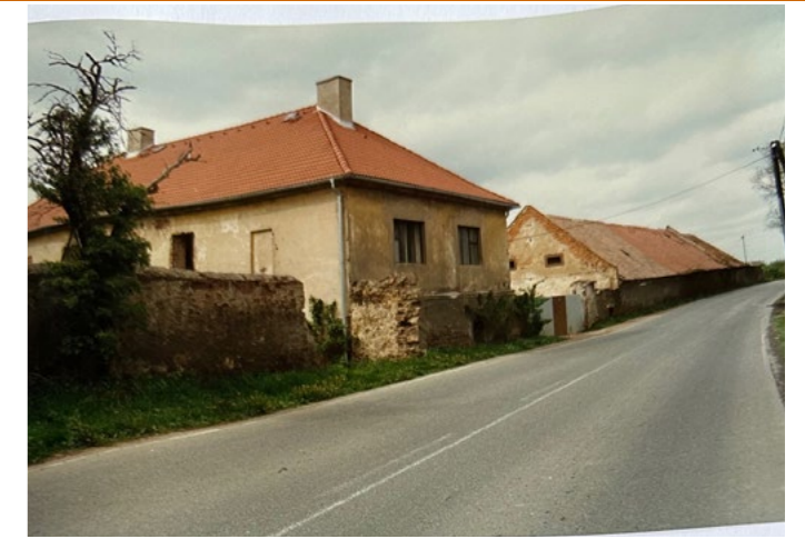
Jižní fasáda obytného stavení (objekty AB)
