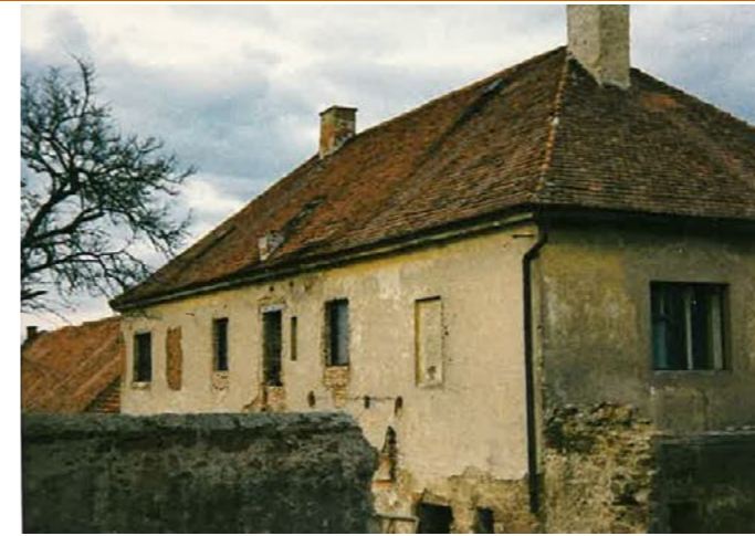
Jižní fasáda obytného stavení (objekty AB)
