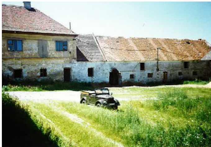
Pohled od sýpky na objekt A
