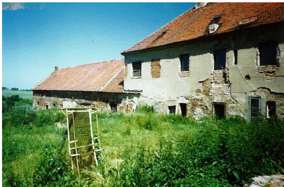
Pohled z komunikace na jižní fasádu objektu A
