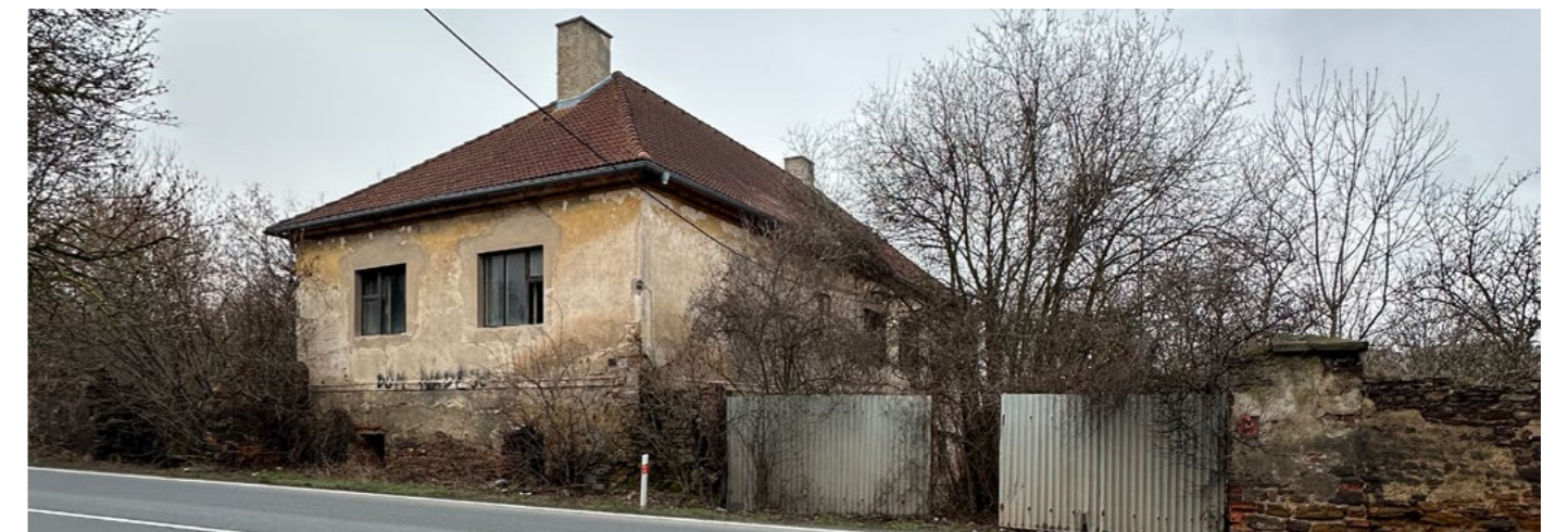
Východní fasáda obytného stavení (objekt A), zdroj: vlastní foto
