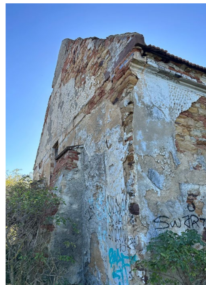
Pohled na severní fasádu, římsa (objekt G)
