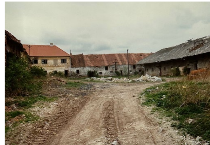
Pohled z nádvoří na objekty ABD, r. 1997
