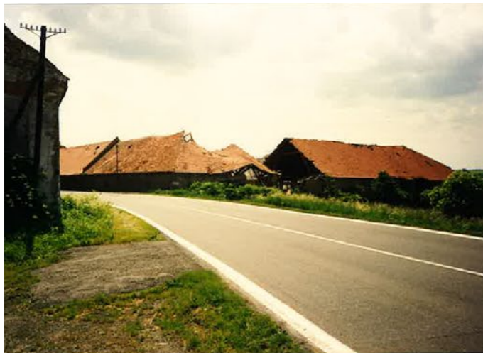
Severní pohled na stodolu (objekt ED)
