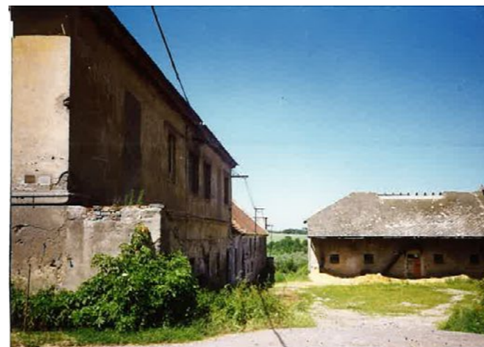
Pohled z komunikace na severní fasádu (objekty AB)
