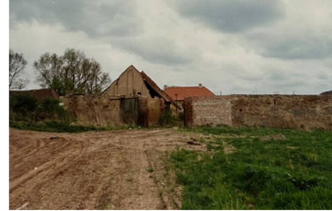
Severní pohled na stodolu (objekt D) r. 1997
