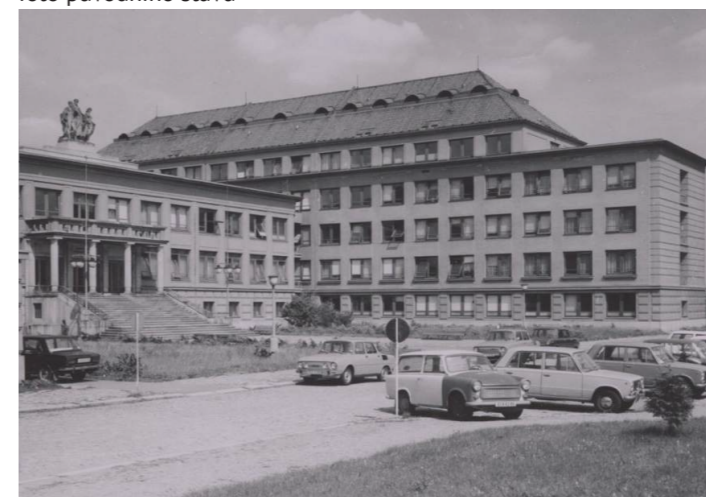
foto hlavního průčelí–1959
