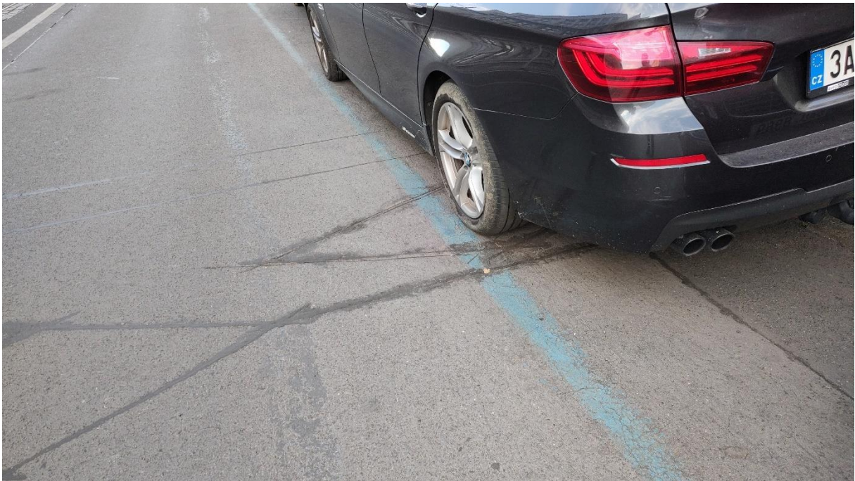
Obr. 21 Indukční smyčky pro monitoring průjezdů cyklistů vedle parkujícího vozidla [zdroj vlastní]
