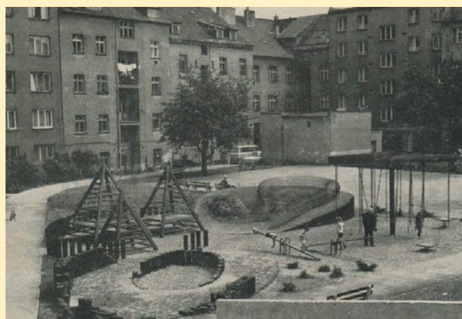
Obr.94 Hřiště ve Vršovicích po dokončení (Zdroj:mlikoamed.cz)
