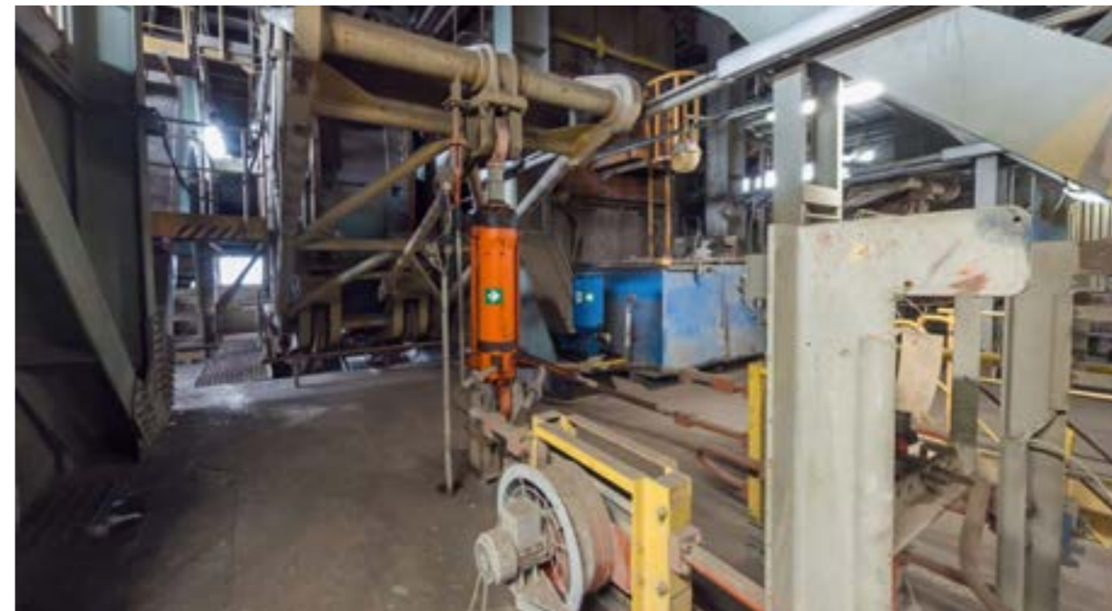
Současný stav interiérů korečkového rypadla RK5000 (zdroj: archiv autora)
