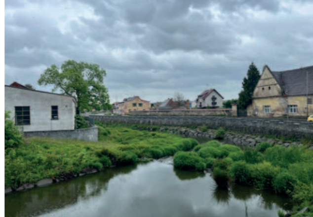
1 - řeka Lomnice, tok od zámku přes zástavbu do volné krajiny - kamenná zeď
