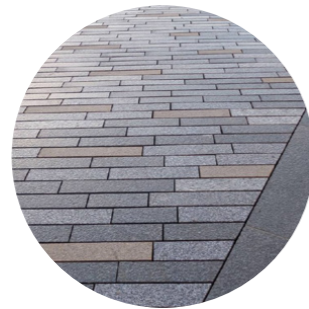
kamenná dlažba - chodníky
