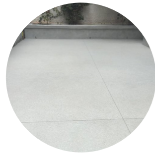
velkoformátová betonová dlažba - víceúčelová plocha
