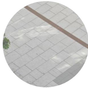
světlá kamenná dlažba
