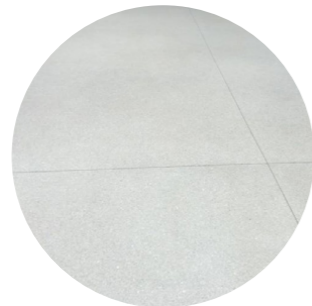
betonová velkoformátová dlažba - centrální předprostor pomníku
