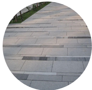
žulová dlažba nepravidelného formátu - promenáda
