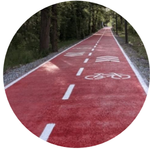
cyklostezka - probarvený asfalt
