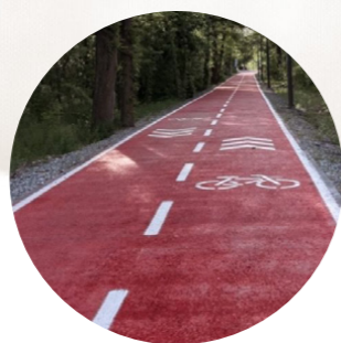
cyklostezka - probarvený asfalt
