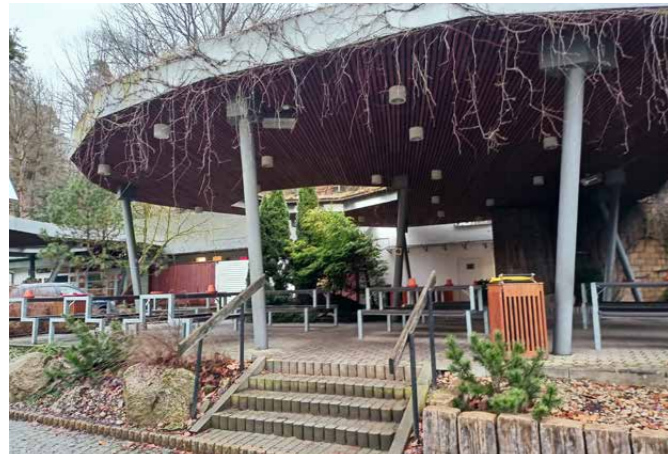
Přístřešek u občerstvení s vegetační střechou. Za deště na návštěvníky prší skrz designovou díru ve střeše.
