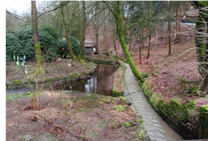
Jizerský potok je v části areálu zatrubněný, ve zbytku teče regulovaným korytem.
