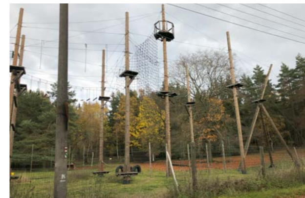
Obr. 137: Lanové centrum Sklárna (foto autorka 6.11.2023)
