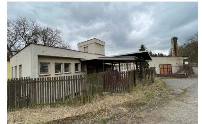
Obr. 174: Budovy jídelny a kuchyně tvořící severní „fasádu“ areálu (foto autorka 14.3.2024)
