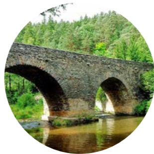
Obr. 29: Kamenný most v Rabštejně nad Střelou (foto Themaspet.cz)
