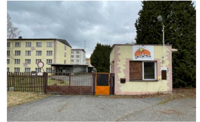
Obr. 173: Současný stav hlavního vstupu z východní strany areálu (foto autorka 14.3.2024)
