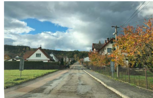
Obr. 125: Zástavba v západní části Žihle (foto autorka 6.11.2023)
