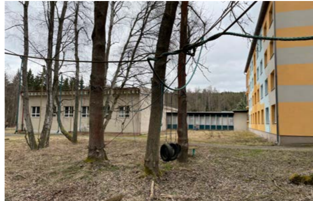
Obr. 179: Pohled z jižní strany areálu, budova tělocvičny (foto autorka 14.3.2024)
