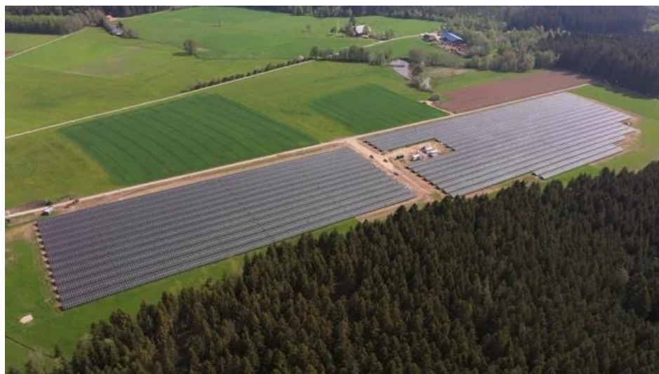
Obrázek 13: Hybridní elektrárna Spitalhöfe v Pfaffenweileru [42]
