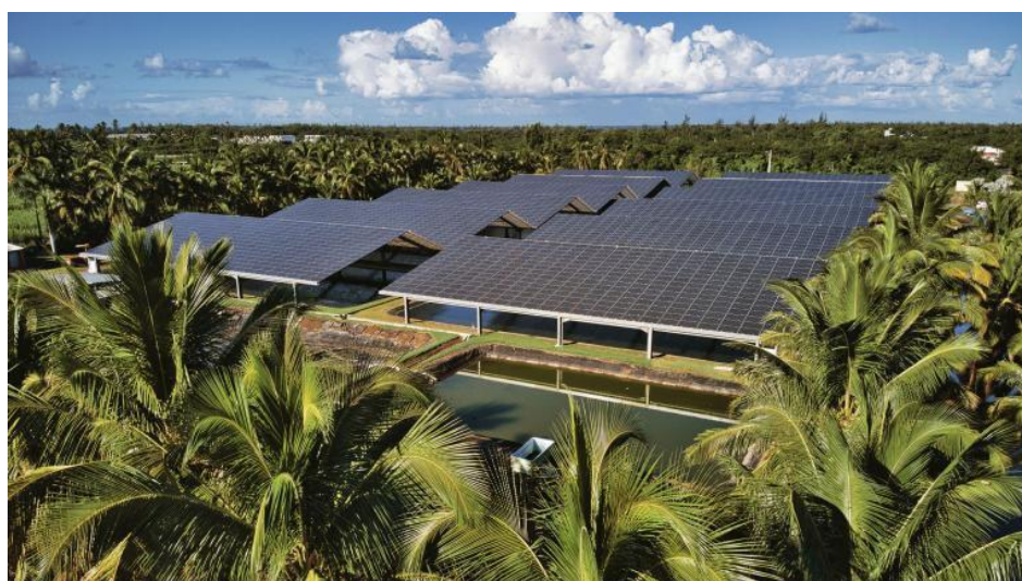
Obrázek 16: Hybridní elektrárna LES CÈDRES [45]
