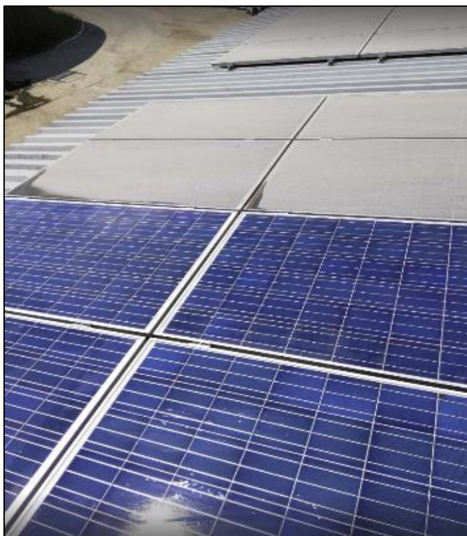
Obrázek 12 Ukázka velmi zašpiněných panelů. Severní Čechy, Ústí nad Labem (osobní zdroj).
