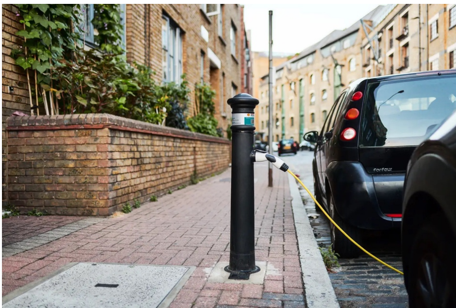
OBRÁZEK 1 UMÍSTĚNÍ NABÍJECÍ INFRASTRUKTURY DO POULIČNÍHO SLOUPKU (UBITRICITY, 2024)
