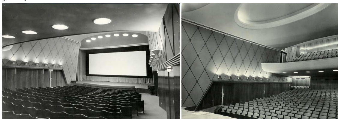
Fig. 4.1.1.7-03 a04 Interiér sálu kina U Hradeb těsně po jeho dokončení, dostupné z: http://stary-web.zastarouprahu.cz/kauzy/mostecka/mostecka3.htm
