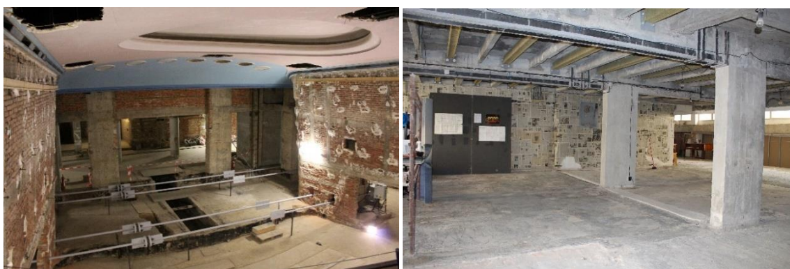
Fig. 4.1.1.7-08 a 09 Interiér sálu a foyer kina U Hradeb během rekonstrukce, 2019, archiv autorky
