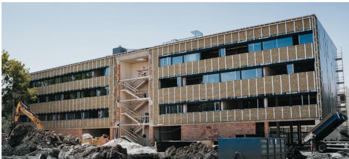
Obrázek 6.1: Z realizace konstrukce [11]
