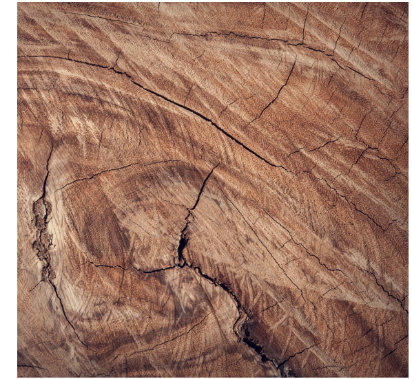
Krov Trámy dřevěného krovu
