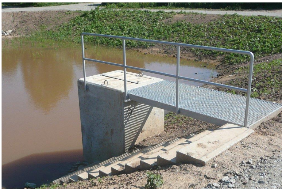
Obrázek 7: Spodní výpust-požerák [47]
