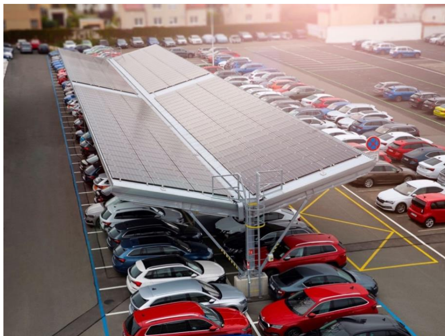
OBRÁZEK 7: FOTOVOLTAIKA NA STŘEŠE PARKOVIŠTĚ
