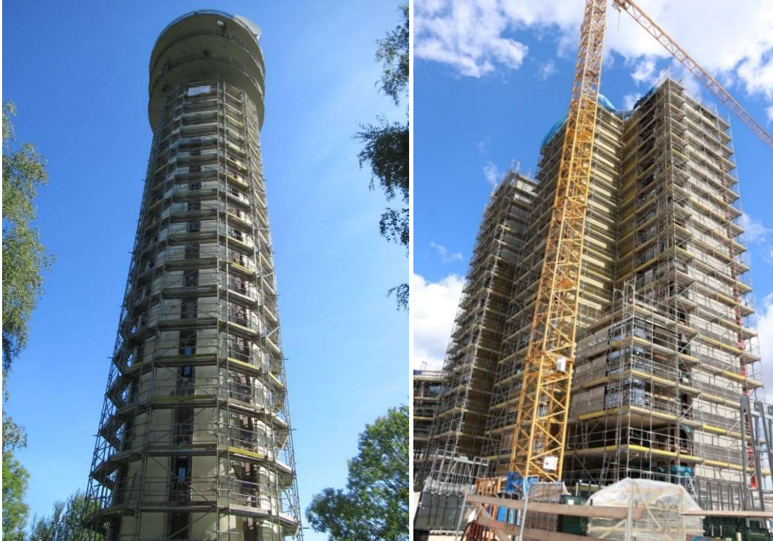
Obr. 17: Lešení Sprint 75 – vodojem Hošťálkovic (vlevo) výstavba bytových domů DOMEQ (Brno) (vpravo) [24]
