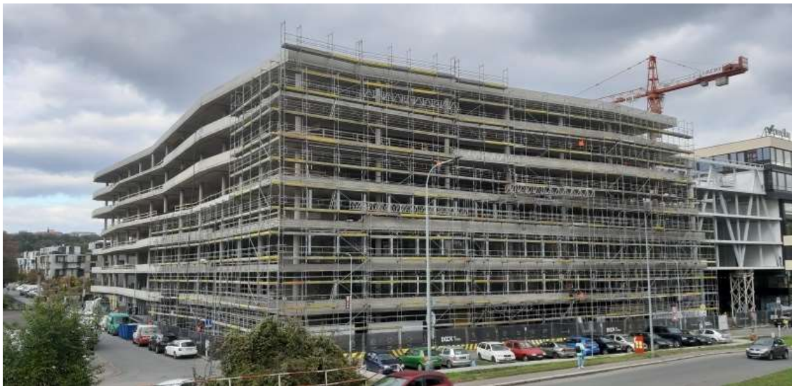
Obr. 16: Lešení Sprint 75 - objekt DOCK 05, Praha (2021) [24]
