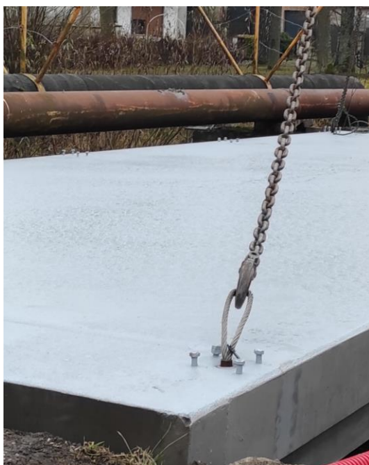
Obr. 108 Hybridní kotevní přípravek „Y“ využitý při manipulaci s dílcem
