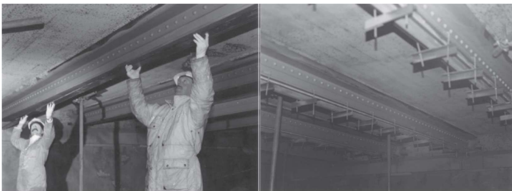
Obrázek 11 Slattocks Canal Bridge, instalace CFRP lamel (vlevo), dočasné připevnění lamel před vytvrzením lepidla (vpravo) [19]
