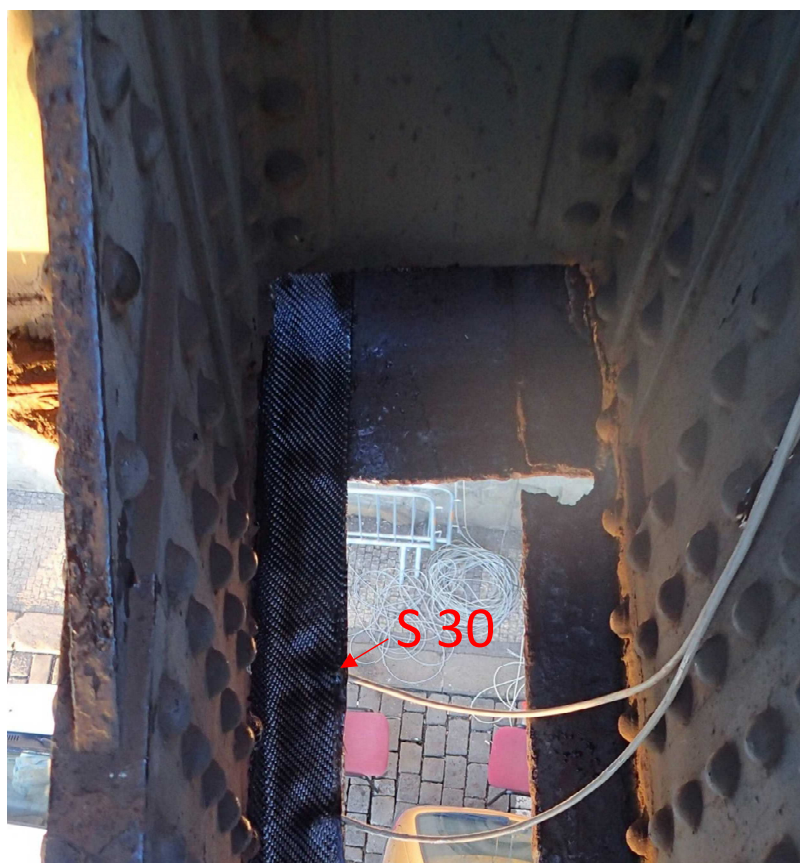
Obrázek 66 Zesílení dolního pásu
