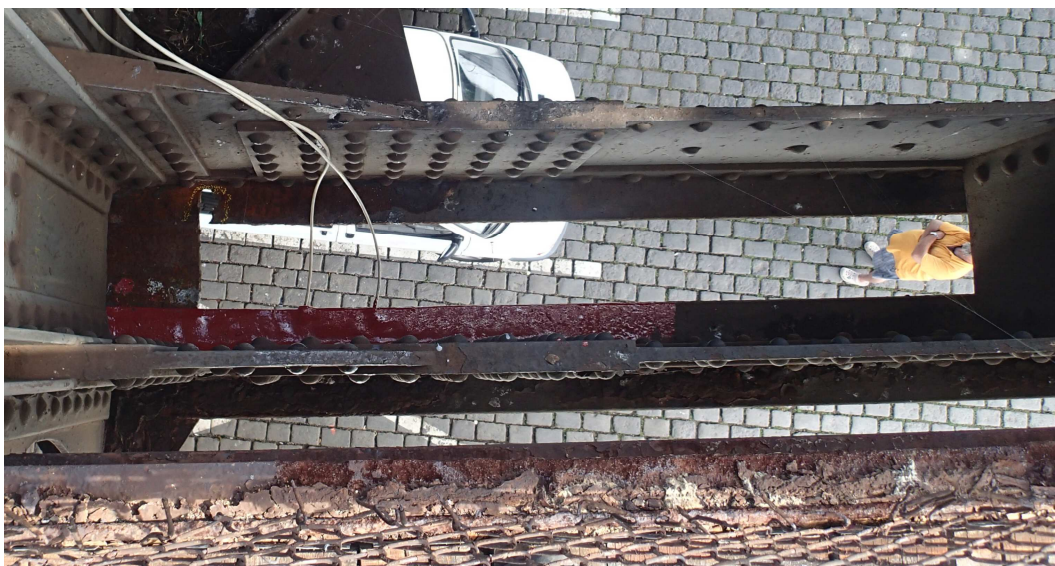
Obrázek 67 Zesílení dolního pásu po aplikaci PKO
