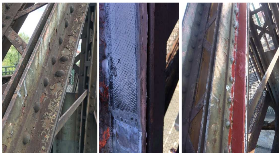
Obrázek 64 Zesílení diagonály, před (vlevo), uhlíková lamela (střed), po aplikaci PKO (vpravo)
