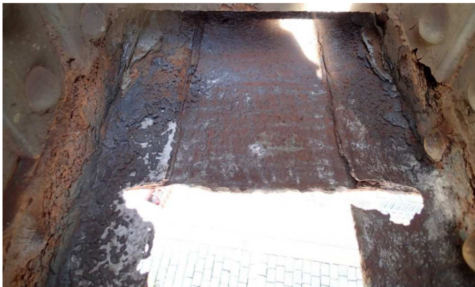
Obrázek 65 Most– dolní pás po otryskání koroze
