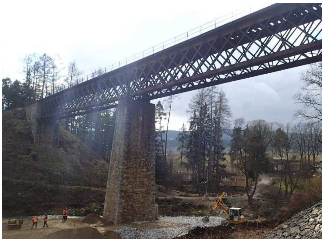
Obrázek 14 Železniční ocelový příhradový most v Holubově
