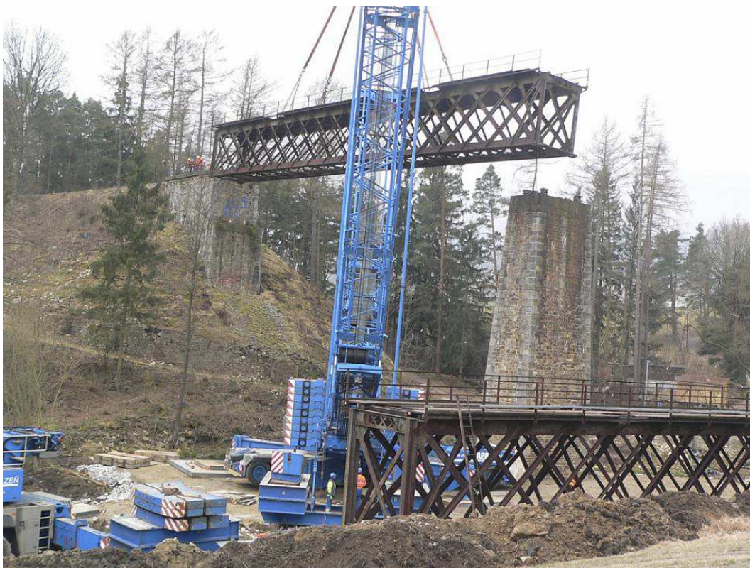
Obrázek 15 Snímání staré konstrukce, most v Holubově
