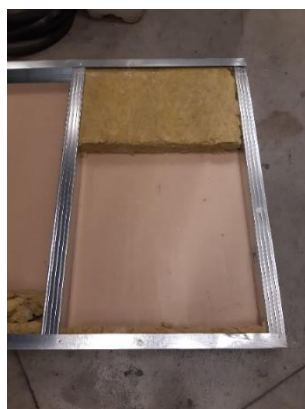
Obrázek 41 Umístění minerální izolace mezi ocelové profily
