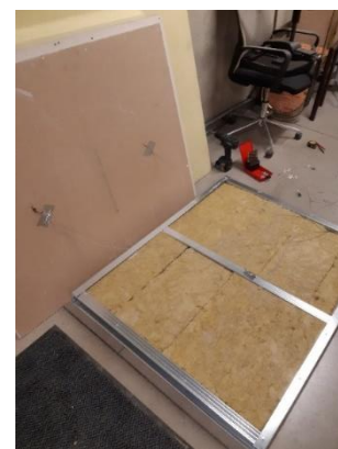
Obrázek 42 Vnitřní skladba před zaklopením desky z horní strany
