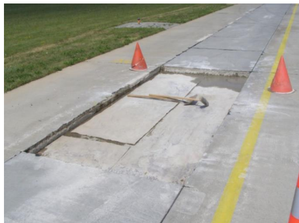
Obrázek 24: Připravený prostor k betonáži
