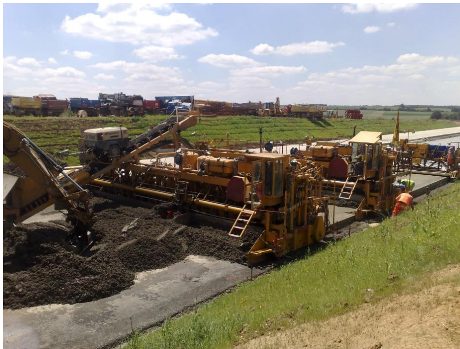
Obrázek 3 Fotografie provádění CB krytu [5]
