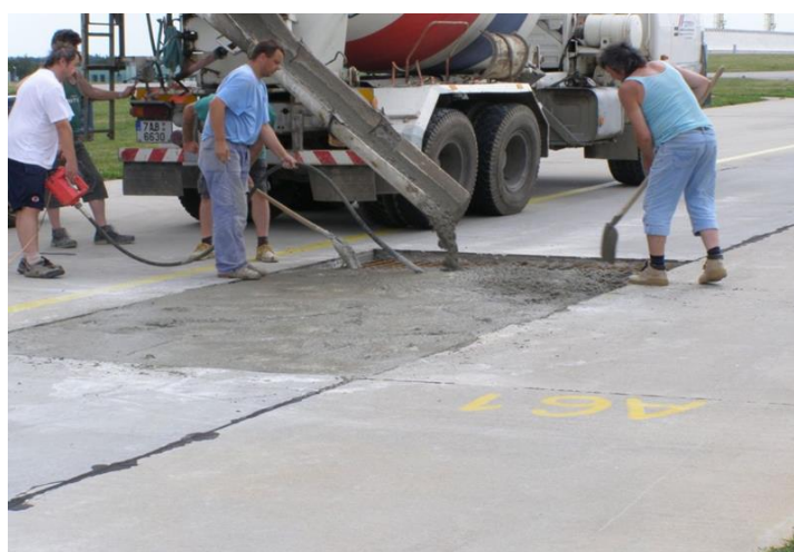
Obrázek 25: Provádění betonáže
