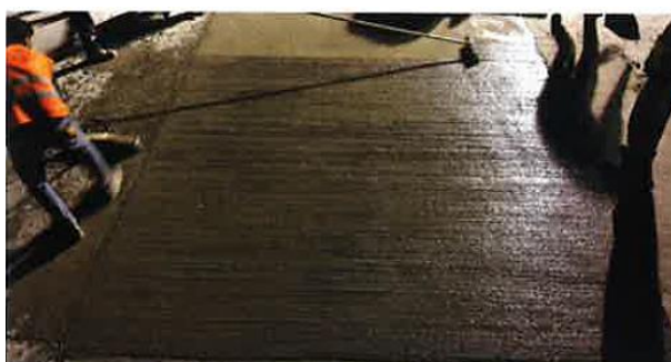
Obrázek 22: Konečná úprava povrchu [2]
