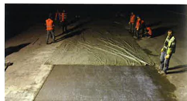
Obrázek 20: Ošetřování betonu přikrytím [2]
