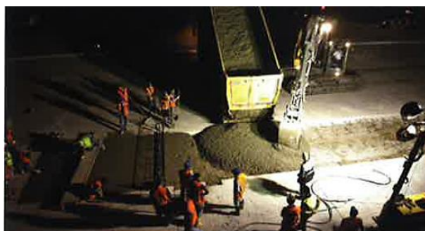
Obrázek 21: Uložení betonu pomocí bagru [2];
