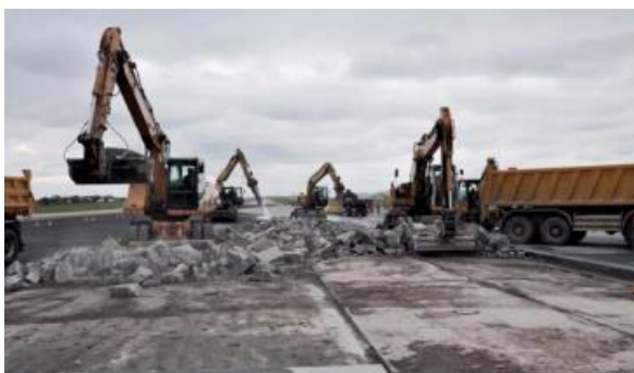
Obrázek 16: Bourání staré betonové desky [14]
