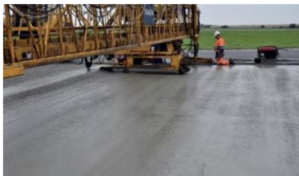
Obrázek 14: Betonáž desky finišerem [14]
