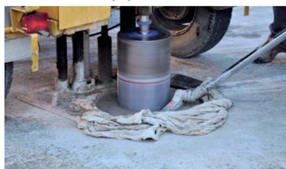
Obrázek 13: Příprava otvorů pro světelnou signalizaci [14]
