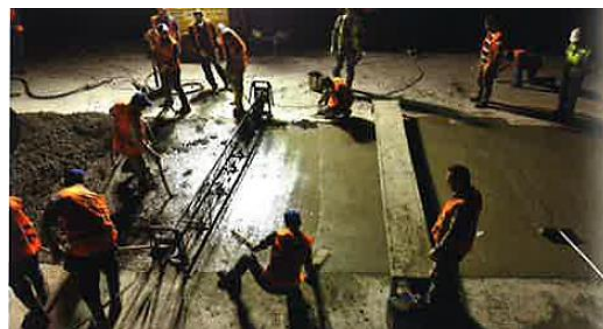
Obrázek 17: Zhutňování betonu [2]
