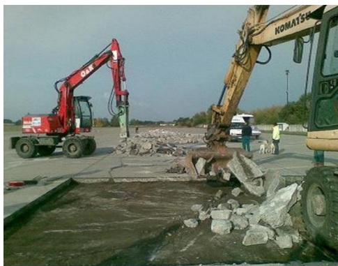
Obrázek 12: Demolice poškozeného CB krytu
