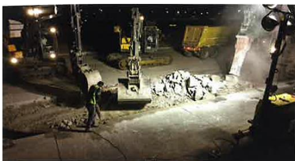
Obrázek 19: Rozbití a likvidace starých desek [2]
