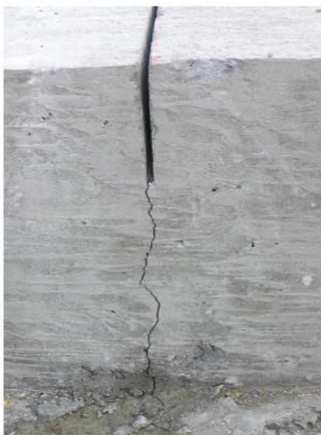
Obrázek 2: Detail smršťovací spáry [11]
