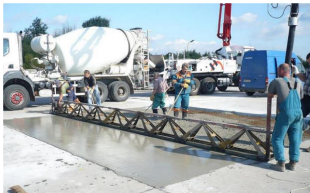
Obrázek 10: Finální betonáž
