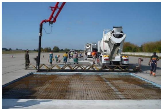
Obrázek 11: Příprava CB desky k betonáži
