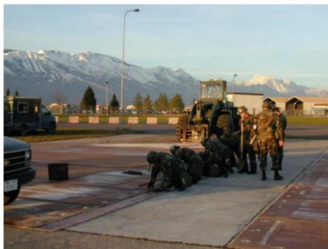
Obrázek 7: kotvení sklolaminátové rohože [42]
