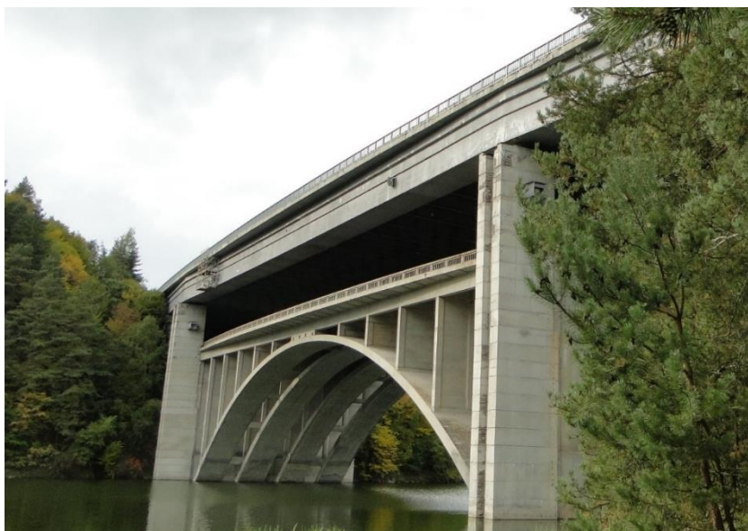
Obrázek 2 Pohled na pravý most od Brněnské opěry
