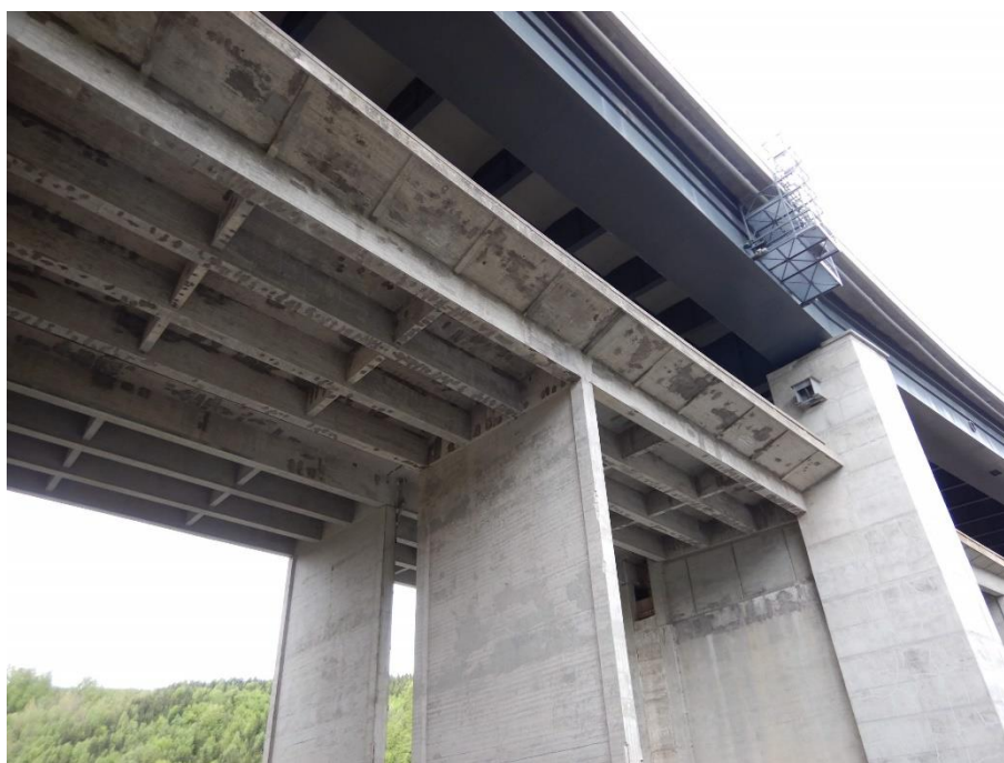
Obrázek 6 Podhled na roštovou mostovku a uložení na P4 a P5 – diagnostika
