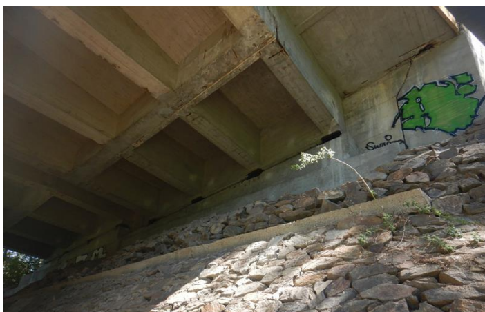
Obrázek 16 Pohled na opěru O6 – HPM
