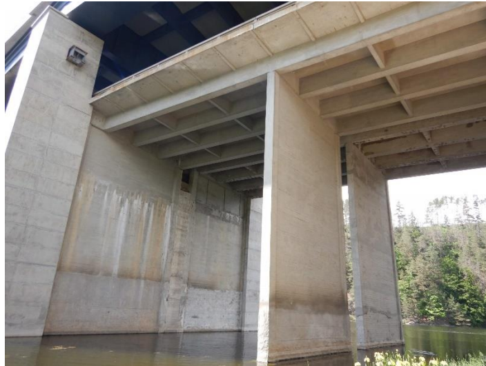
Obrázek 17 Pohled na kyvnou stojku P5 – diagnostika
