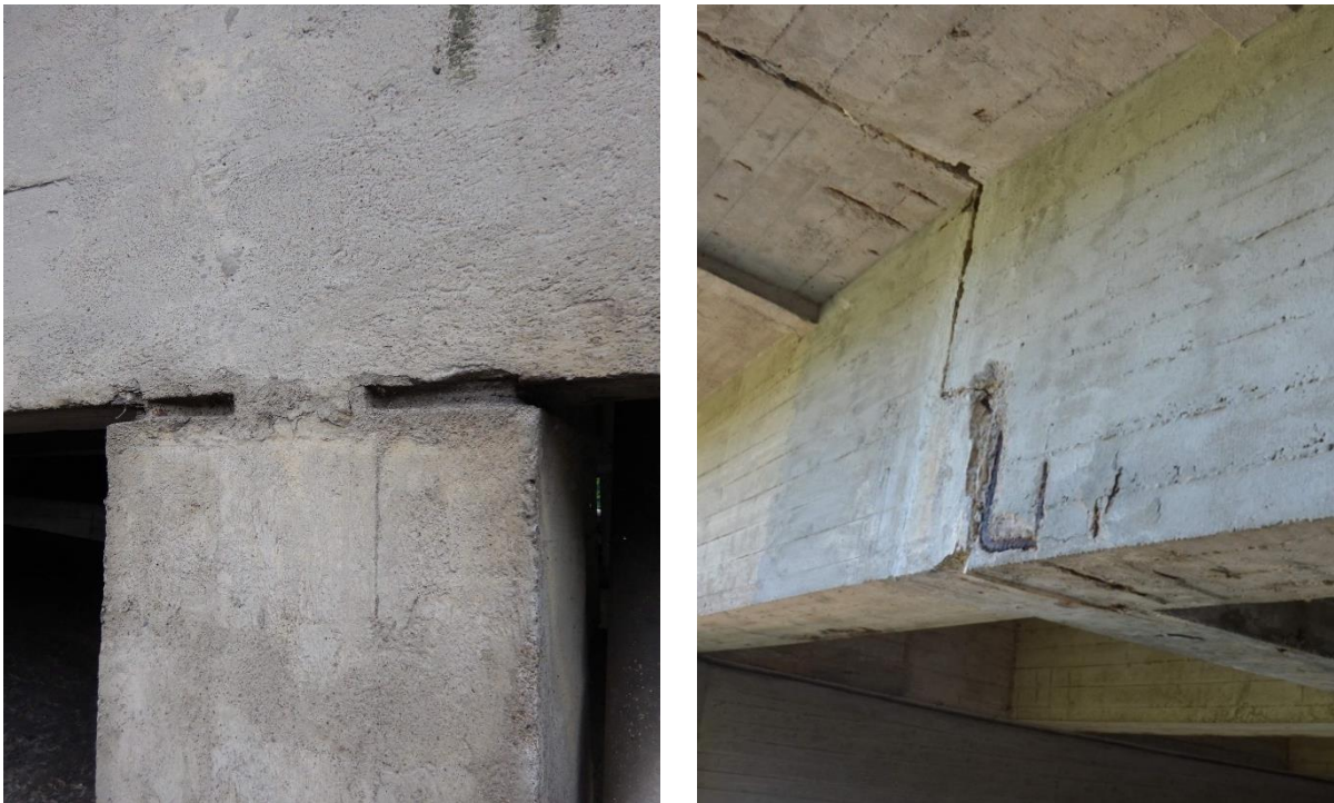
Obrázek 9 Vlevo vrubový kloub v hlavě kyvné stojky a vpravo uložení krajního pole na ozub – diagnostika
