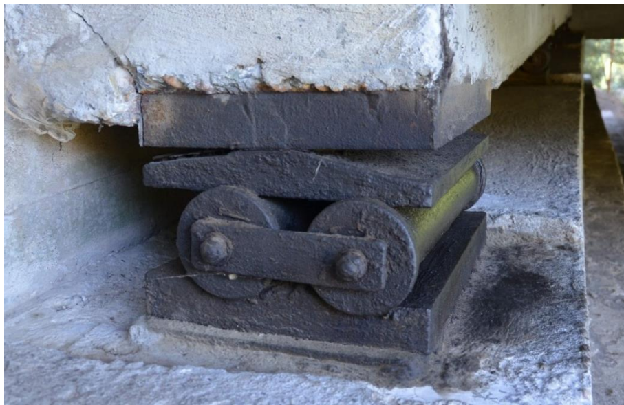
Obrázek 10 Jednosměrné ocelolitinové válečkové ložisko – diagnostika
