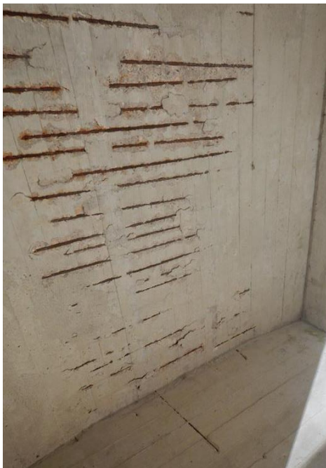
Obrázek 18 Podhled trám a deska mostovky – diagnostika
