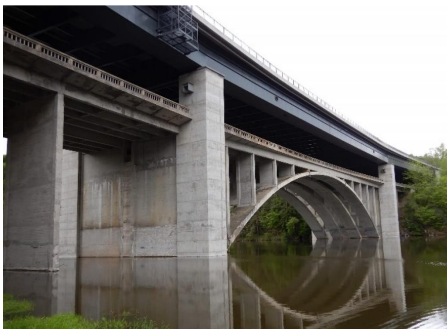
Obrázek 5 Pohled na most zprava – založení pod hladinou vody – diagnostika
