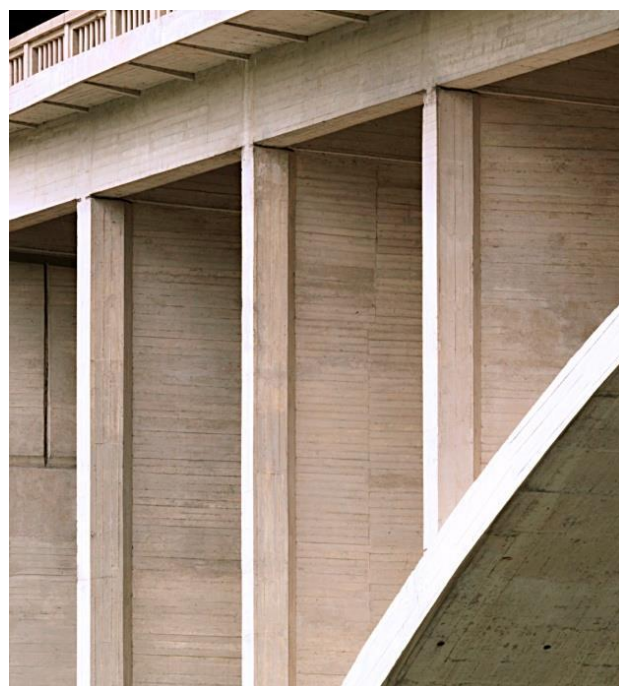
Obrázek 20 Pohled na kyvné stěnové stojky – diagnostika
