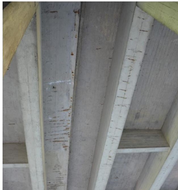
Obrázek 18 Podhled trám a deska mostovky – diagnostika
