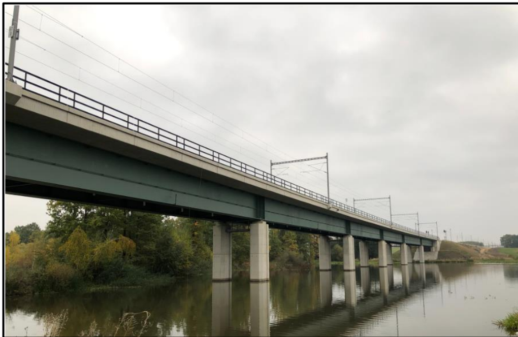
Obrázek 30: Pohled na most
