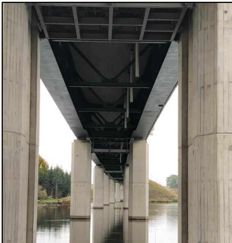
Obrázek 33: Pohled pod mostem
