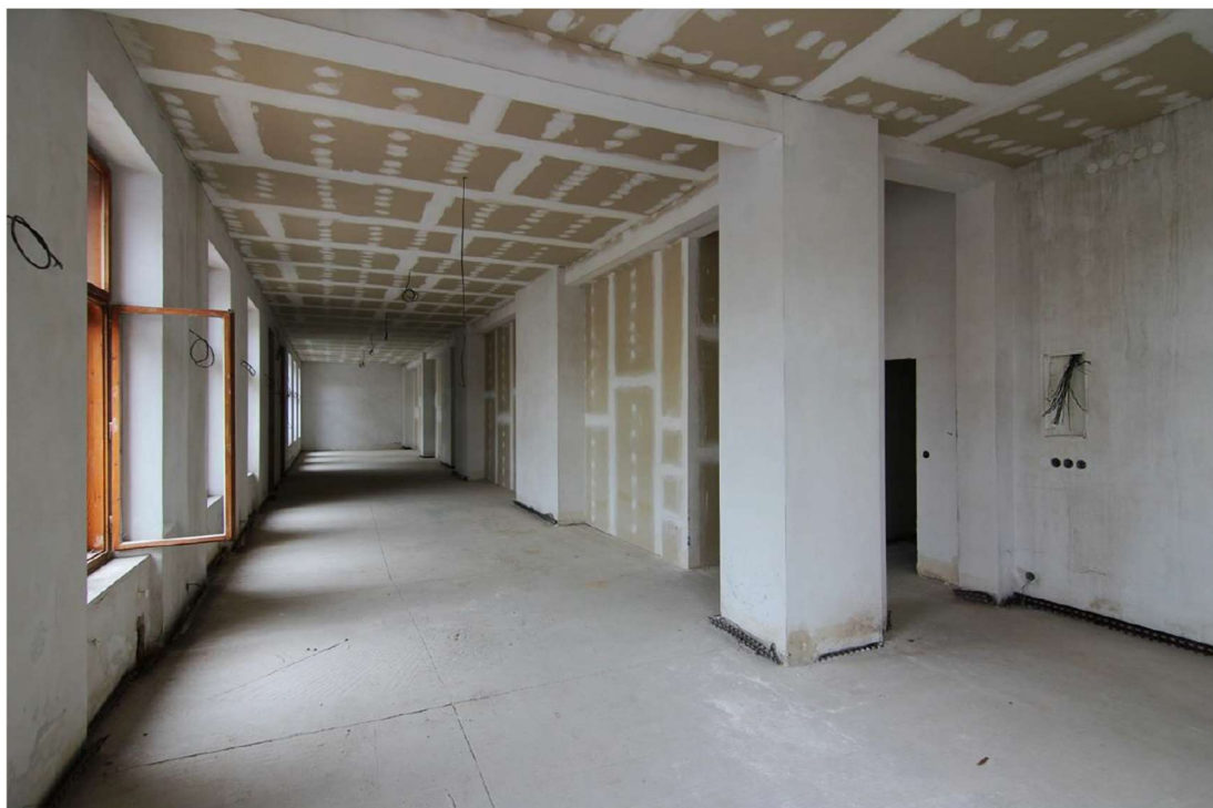
Obrázek 6 - Foto stávajícího stavu před započítím prací
