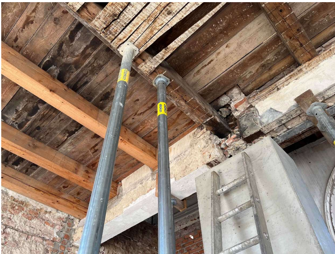
Obrázek 8 - Foto dočasného podepření individuálního prvku
