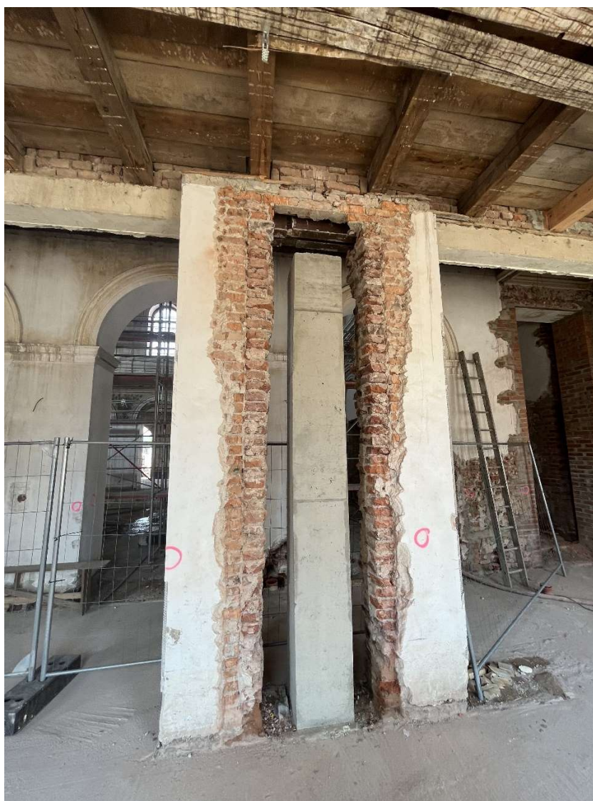
Obrázek 12 - Foto monolitické části sloupu
