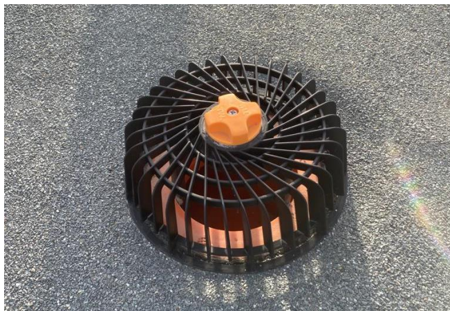
Obr. č. [12] Demontovatelná a snadno přístupná mřížka proti průniku splavenin do kanalizace
