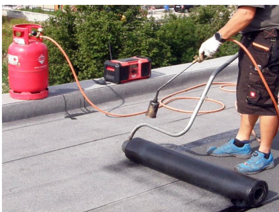
Obr. č. [1] Plošné natavování asfaltového pásu pomocí ocelové trubky
