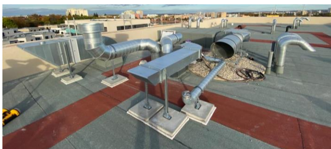
Obr. č. [35] Příklady míst, kam není možné zajet defektoskopem „2“ (vlastní fotodokumentace)
