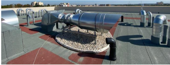
Obr. č. [36] Příklady míst, kam není možné zajet defektoskopem „3“ (vlastní fotodokumentace)
