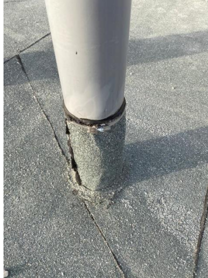
Obr. č. [53] Fotodokumentace pro posouzení celkové kvality provedení vrstvy hydroizolace „1“ (vlastní fotodokumentace)
