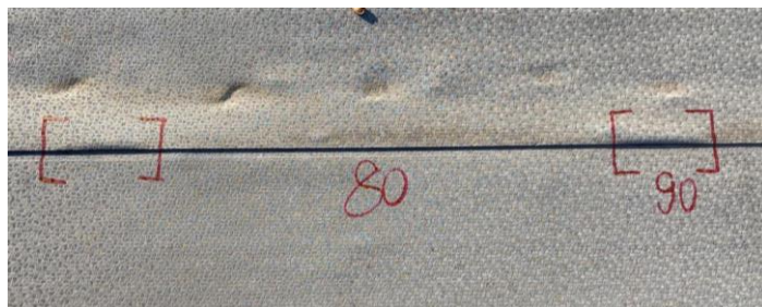
Obr. č. [22] Defekty s detekovanou zvýšenou mírou vlhkosti (vlastní fotodokumentace)
