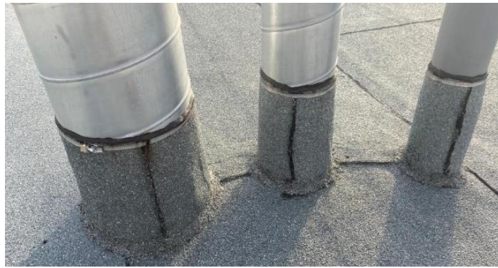
Obr. č. [39] Příklady míst, kam není možné zajet defektoskopem „6“ (vlastní fotodokumentace)
