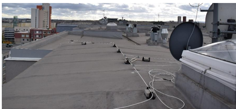
Obr. č. [17] Zhodnocení stavu a konstrukce střechy (vlastní fotodokumentace)
