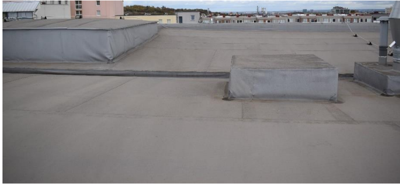
Obr. č. [18] Zhodnocení stavu a konstrukce střechy (vlastní fotodokumentace)
