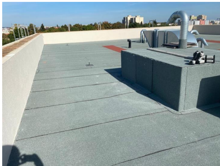
Obr. č. [54] Fotodokumentace pro posouzení celkové kvality provedení vrstvy hydroizolace „2“ (vlastní fotodokumentace)
