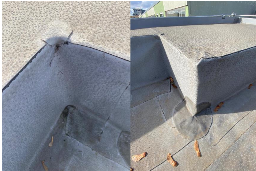
Obr. č. [19] Zhodnocení stavu a konstrukce střechy (vlastní fotodokumentace)
