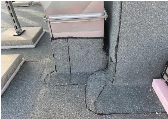
Obr. č. [38] Příklady míst, kam není možné zajet defektoskopem „5“ (vlastní fotodokumentace)
