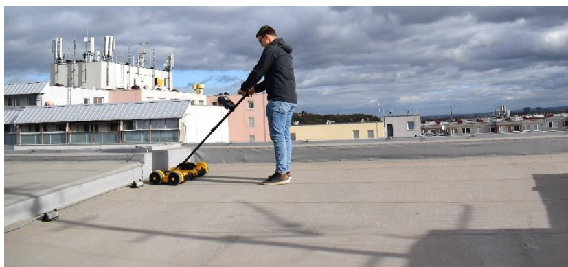
Obr. č. [21] Měření míry vlhkosti v pravidelném rastru (vlastní fotodokumentace)
