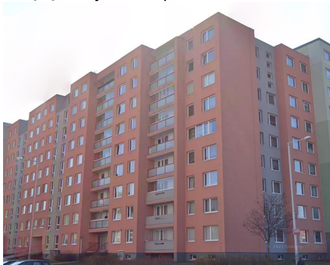
Obr. č. [16] Panelový dům VVÚ-ETA Praha - Stodůlky
