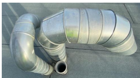
Obr. č. [34] Příklady míst, kam není možné zajet defektoskopem „1“ (vlastní fotodokumentace)
