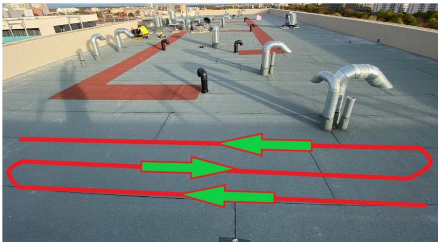
Obr. č. [33] Směr pojezdu defektoskopu na střešní krytině (vlastní fotodokumentace)
