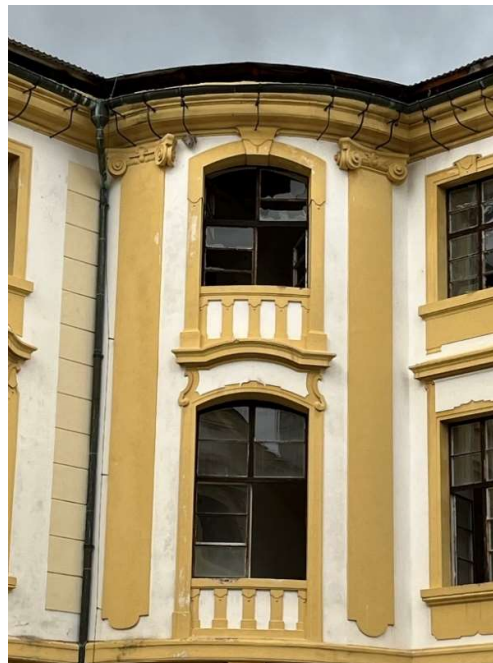
Obrázek 137 - Ohořelé a chybějící okenní výplně, deštění a okenice Obrázek 138 - Rozbité a chybějící skleněné výplně
