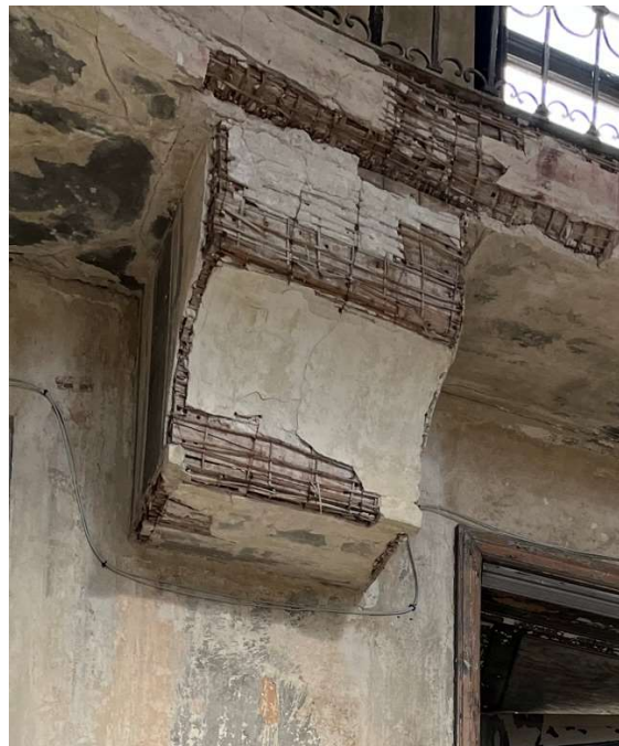
Obrázek 165 Detailní pohled na opadanou a ohořelou vrstvu omítky, odhalená vrstva rákosu na desce a krakorci balkonu ve velkém sále
