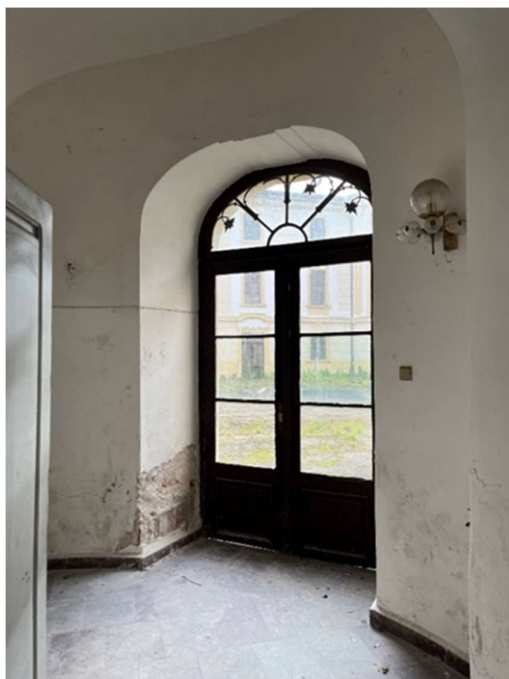
Obrázek 72 - Pohled na dveře v přízemí čtvrtválcového výstupku
