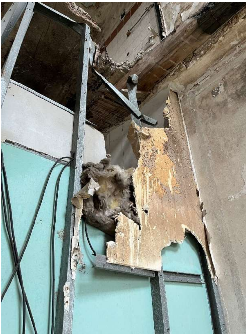
Obrázek 75 - Příklad stávající lehké dělící příčky
