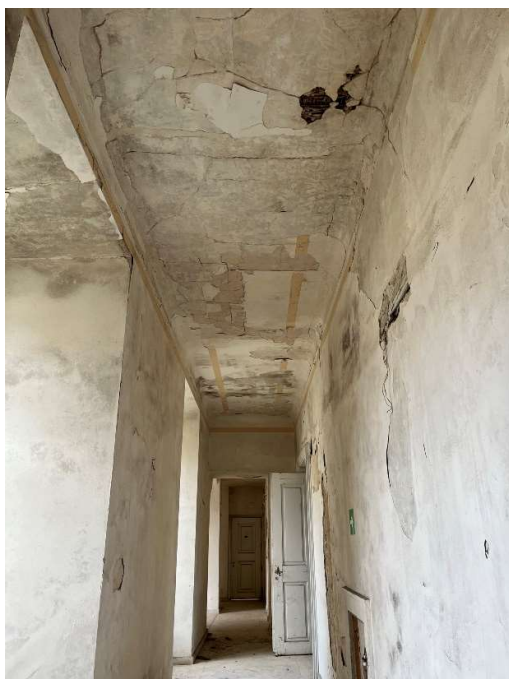
Obrázek 105 - Opadaná a prohnutá rákosová omítky v chodbě 1.NP ve východní části
