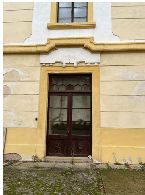
Obrázek 73 - Pohled na dveře do sklepení v západním křídle
