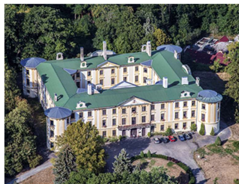
Obrázek 5 - Letecká fotografie zámku po instalaci provizorního krovu [6]
