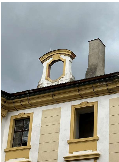
Obrázek 83 - Pohled dvorní na zděnou konstrukci vikýře a stávající kaminové těleso
