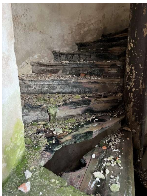
Obrázek 39 - Pohled na schodišťové stupně
