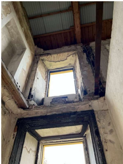
Obrázek 137 - Ohořelé a chybějící okenní výplně, deštění a okenice Obrázek 138 - Rozbité a chybějící skleněné výplně
