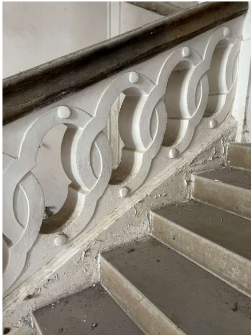
Obrázek 33 - Detailní pohled na zábradlí
