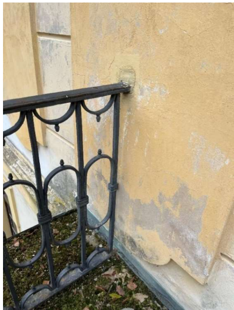
Obrázek 88 - Detail uložení zábradlí do obvodové stěny
