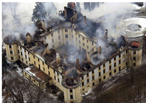
Obrázek 4 - Letecká fotografie zámku po požárním zásahu [5]
