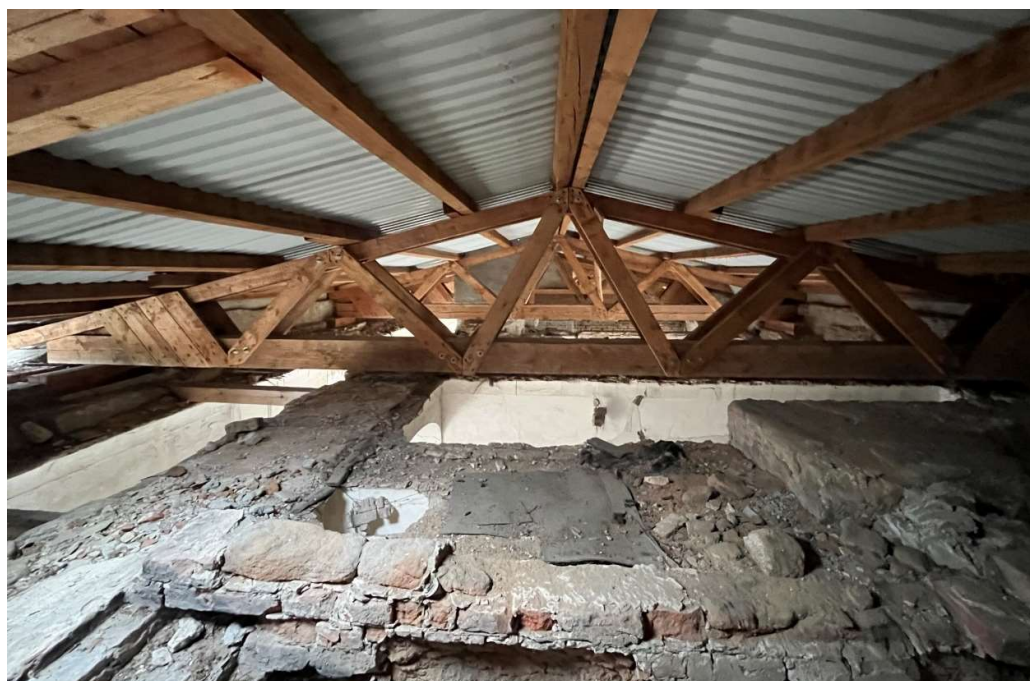
Obrázek 44 Pohled na plnou vazbu nosného systému provizorního krovu
