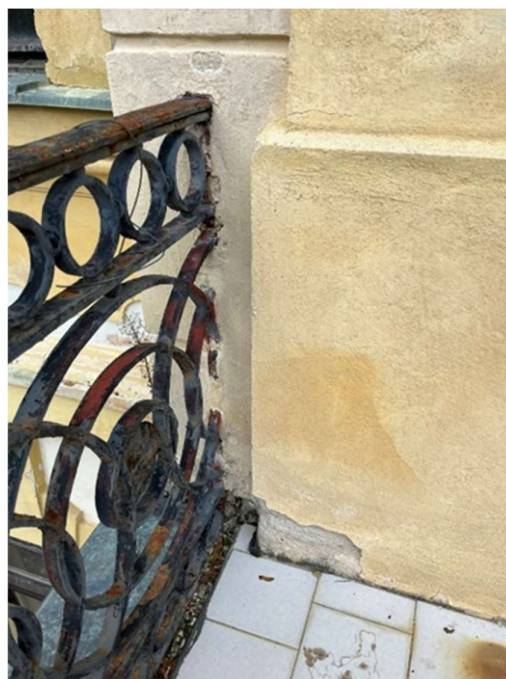
Obrázek 87 - Detail kotvení zábradlí do obvodové stěny
