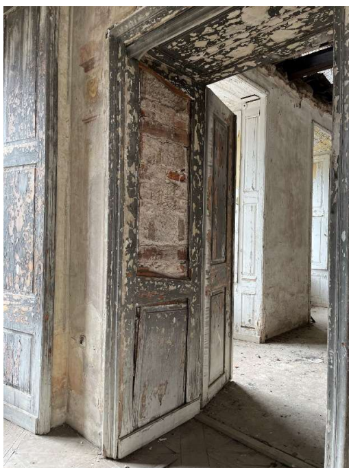
Obrázek 67 - Dveře dvoukřídle dřevěné s širokým dřevěným deštěním
