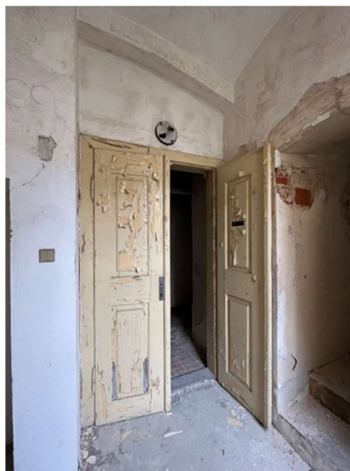
Obrázek 68 - Dveře dřevěné dvoukřídle s nátěrem
