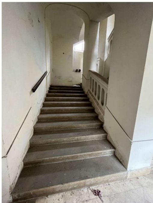
Obrázek 35 - Pohled na schodiště z přízemí
