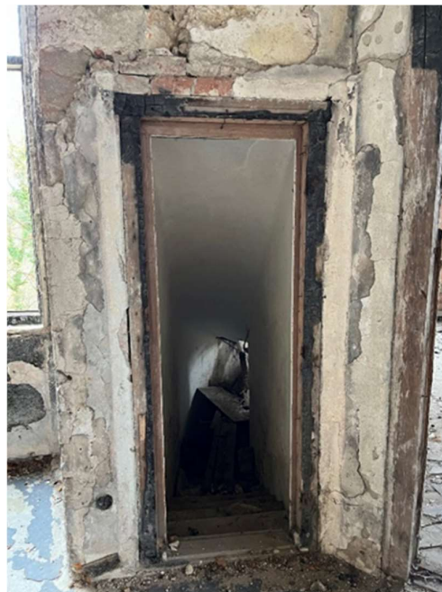
Obrázek 42 - Pohled na vstup na schodiště
