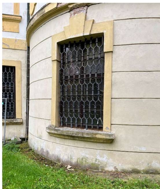
Obrázek 65 - Okno na JZ rondelu s lemující šambránou, parapet bez oplechování, bez spádování, mříž po celé ploše okna
