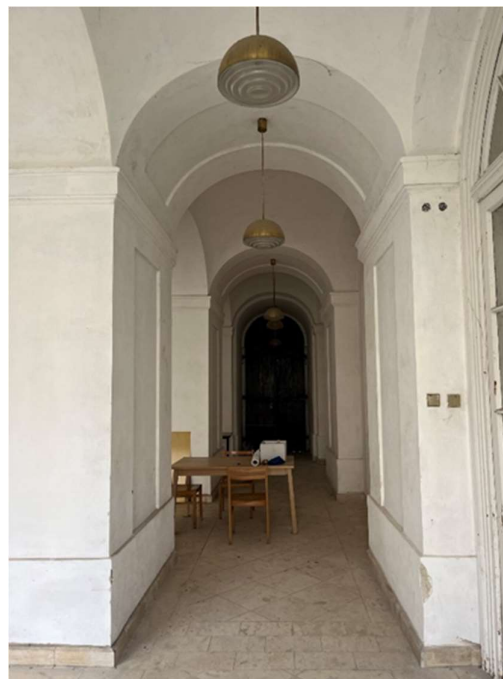
Obrázek 19 - Pohled do boční části průjezdu (0.01)
