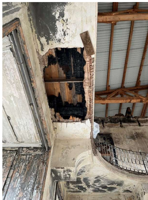
Obrázek 167 - Prohořelé souvrství balkonu
