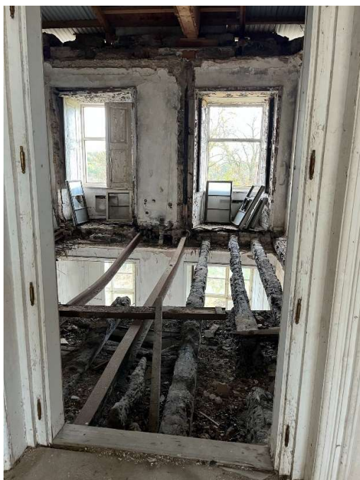
Obrázek 115 - Pohled na stropní konstrukci ve východním křídle z 2.NP
