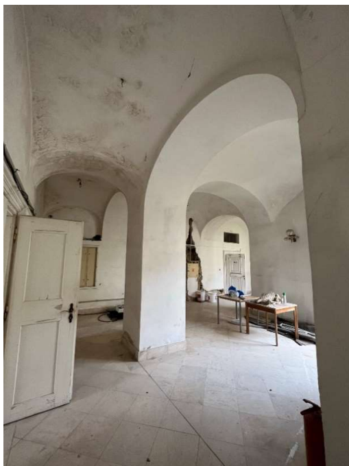
Obrázek 26 - Pilíř v chodbě u JV čtvrtálcového výstupku
