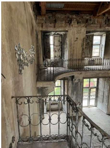
Obrázek 90 - Balkon velký sál – pohled na zábradlí
