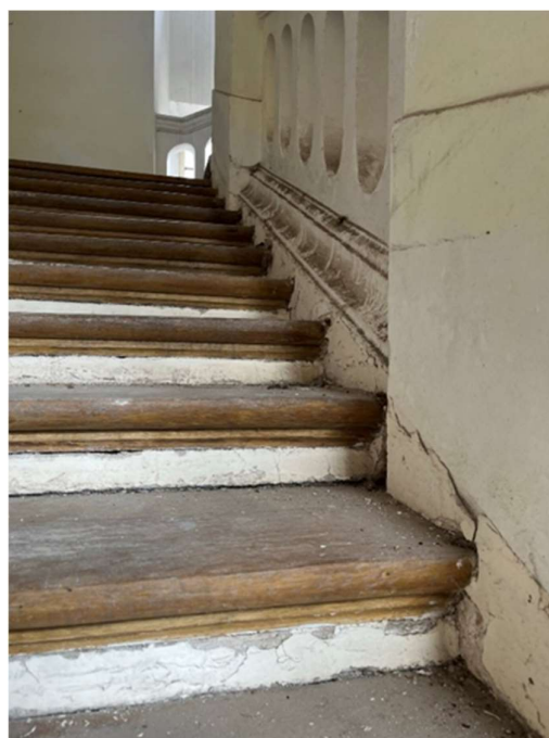
Obrázek 38 - Detailní pohled na schodišťové stupně z 1.NP
