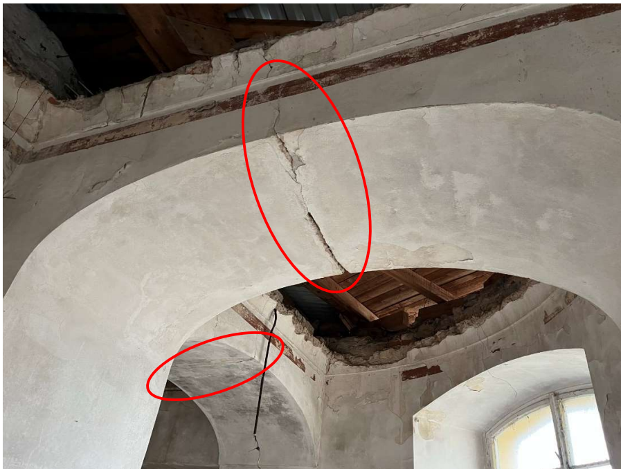
Obrázek 117 - Trhliny v klenbových pásech u SV čtvrtválcových výstupků ve 2.NP
