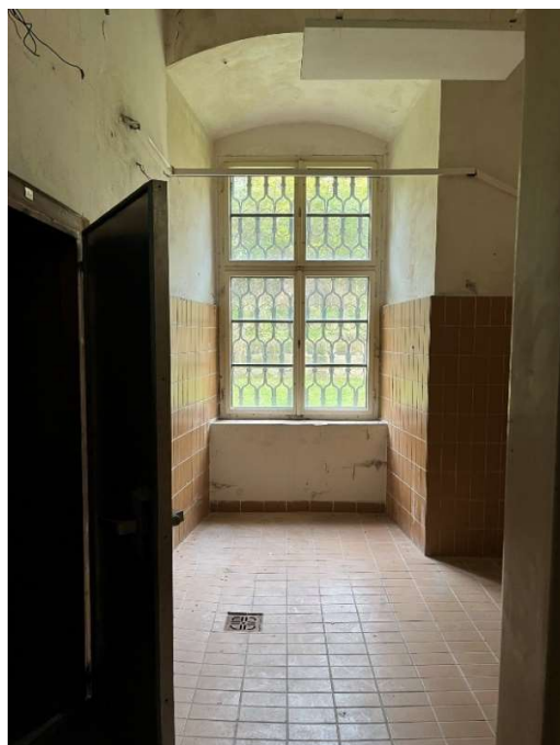
Obrázek 78 - Keramická dlažba přízemí chodba
