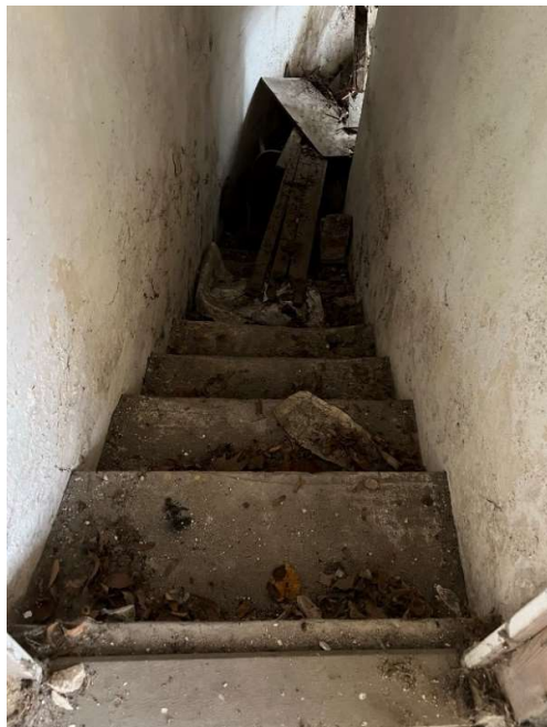
Obrázek 41 - Pohled na schodišťové stupně
