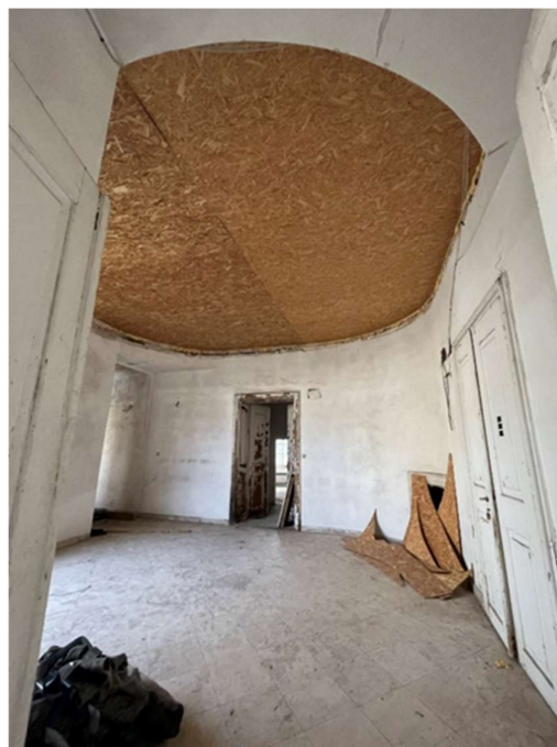
Obrázek 29 - Provizorní lokální bednění nad 1.NP v chodbě u JV čtvrtválcového výstupku (1.04)
