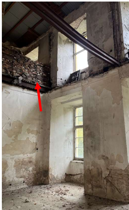
Obrázek 11 - Zdivo z cihel plných pálených ve 2.NP Obrázek 12 - Zdivo z pískovcových bloků v 1.NP
