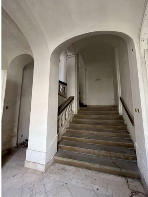
Obrázek 31 - Schodišťové rameno z přízemí
