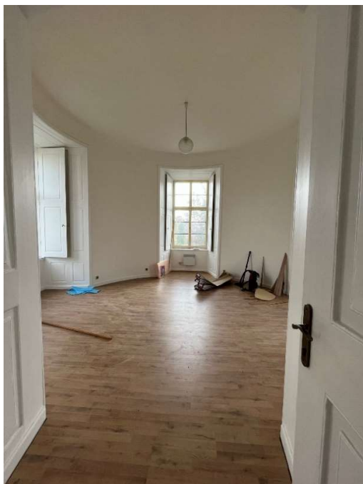
Obrázek 28 - Rekonstrukce místnosti č. 1.06 – JV rondel, nová stropní konstrukce nad 1.NP
