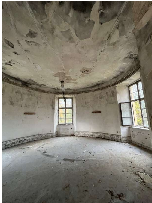
Obrázek 155 - Zvlněné PVC šablony v místnosti č.1.22
