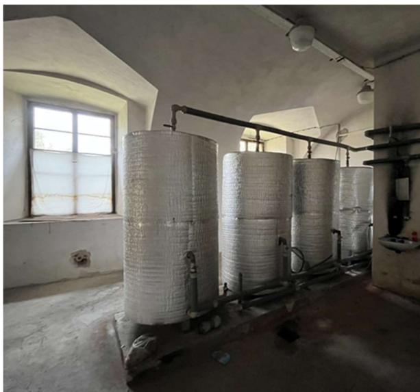
Obrázek 46 - Přístavek v severní části, zásobníky TV
