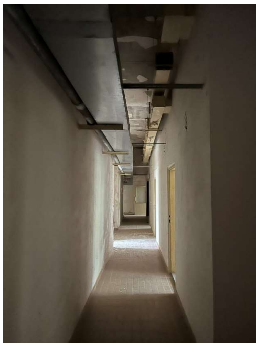
Obrázek 22 - Místnost č. 0.40 - Chodba
