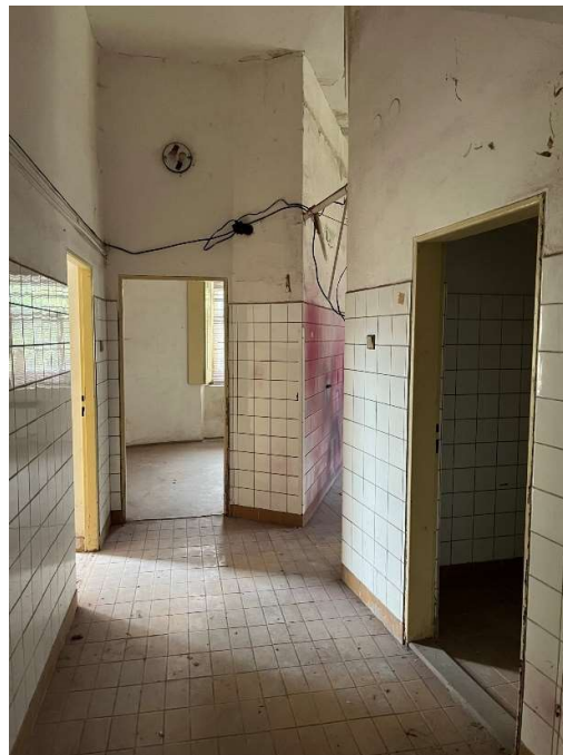
Obrázek 70 – Ocelové zárubně bez osazených dveřních křídel
