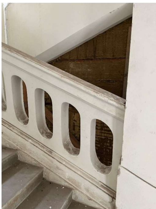
Obrázek 37 - Detailní pohled na zábradlí
