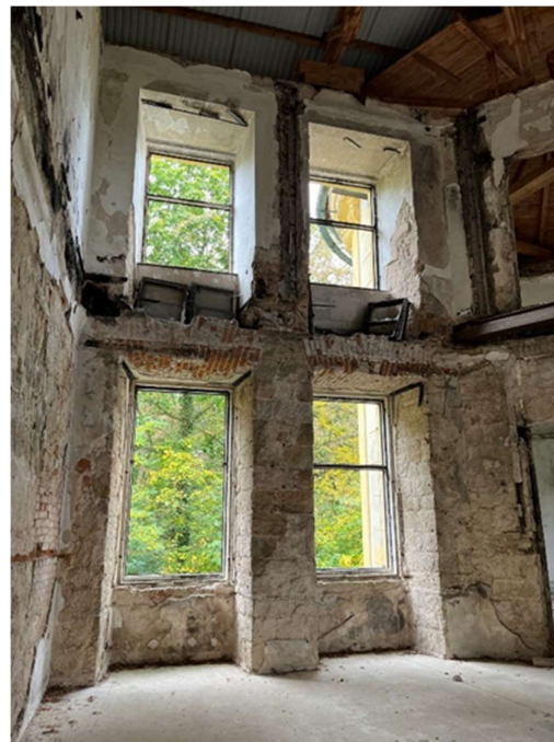
Obrázek 11 - Zdivo z cihel plných pálených ve 2.NP Obrázek 12 - Zdivo z pískovcových bloků v 1.NP
