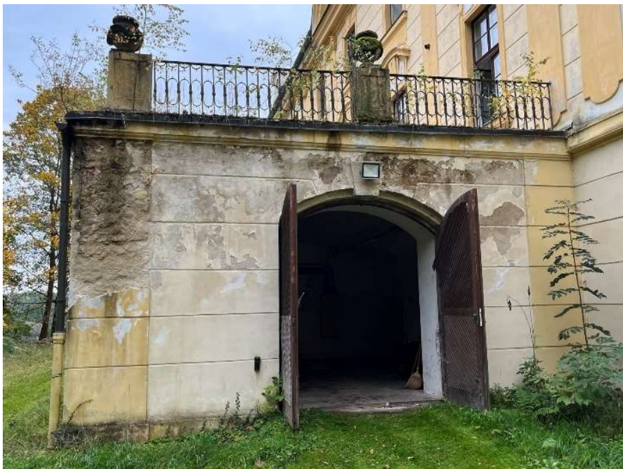
Obrázek 74 – Dvoukřídlá vrata pro vjezd do přístavku
