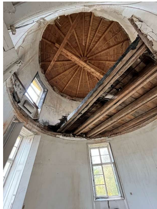
Obrázek 111 - Část stropní konstrukce v místnosti č. 1.29 a odhalené ohořelé stropní trámy
