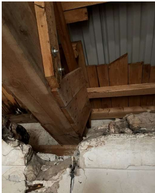
Obrázek 43 Detailní pohled na uložení vazníku provizorního krovu
