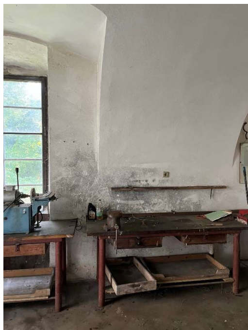
Obrázek 94 - Výskyt plísní na vnitřní stěně severního přístavku
