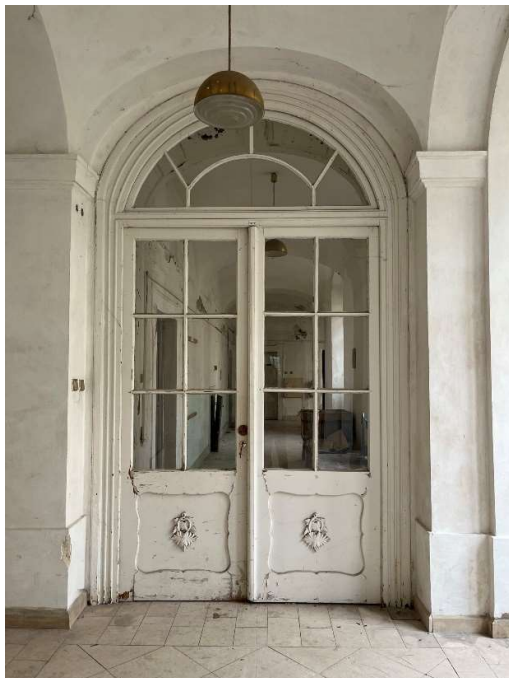
Obrázek 69 - Dveře z průjezdu do chodby
