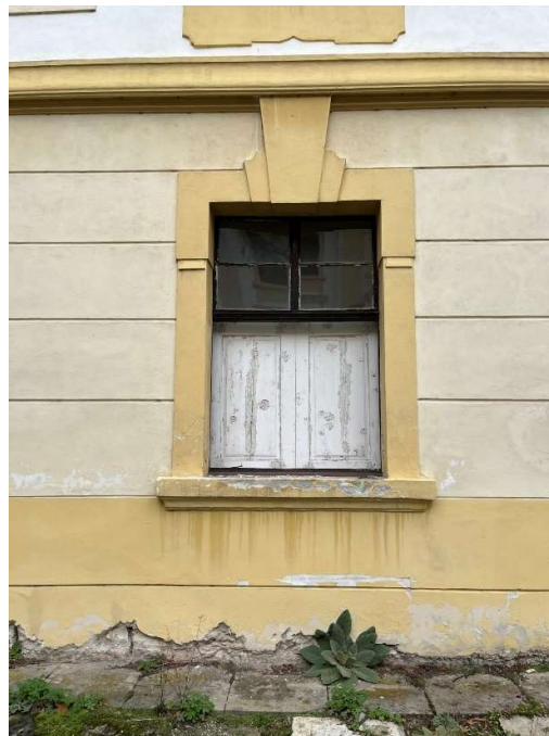
Obrázek 141 - Provizorní část výplně otvoru
