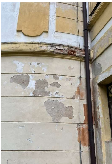
Obrázek 172 - Pohled na dešťový svod probíhající patrovou římsou (západní část - SZ rondel)
