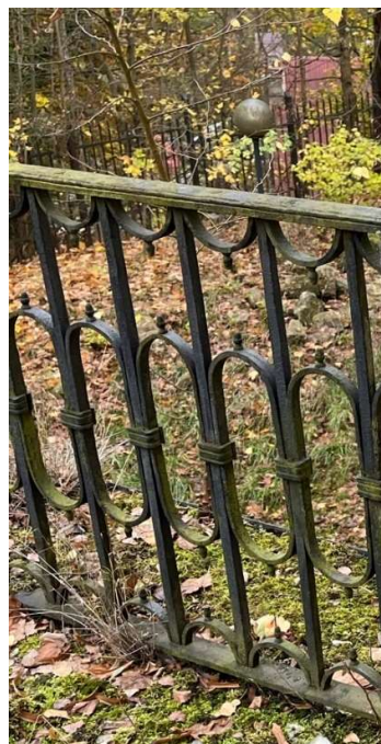
Obrázek 169 - Zábradlí pokryto vrstvou mechu
