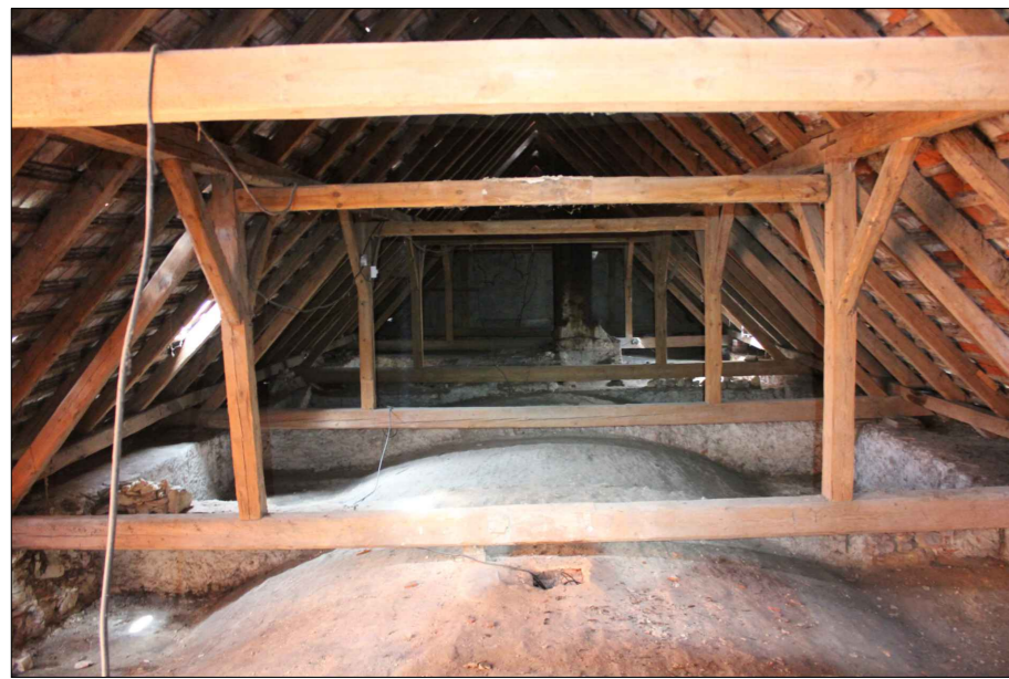
POHLED NA KROV
