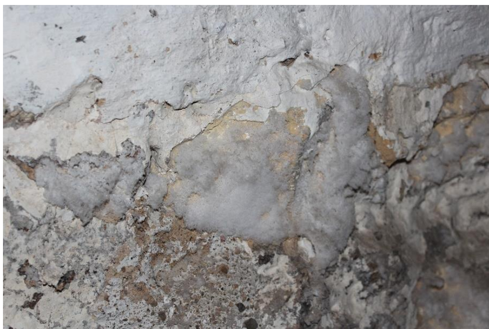
Obrázek 29 – Zdivo napadené solemi
