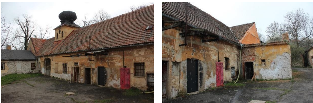
Obrázek 11 - Pohled na budovu B (západní strana)
