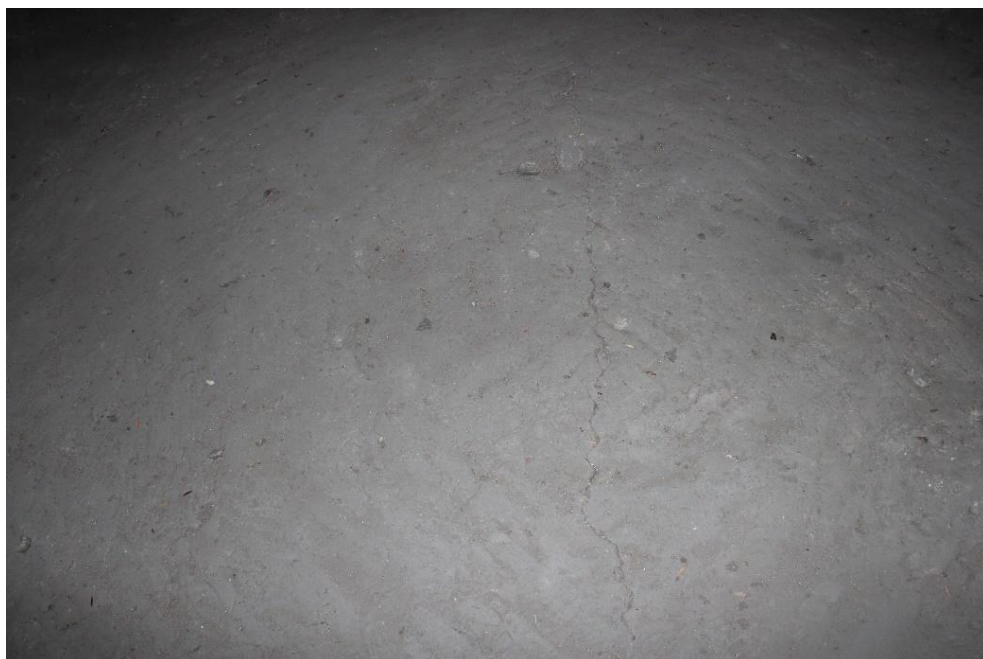
Obrázek 33 – Trhлина z horní strany
