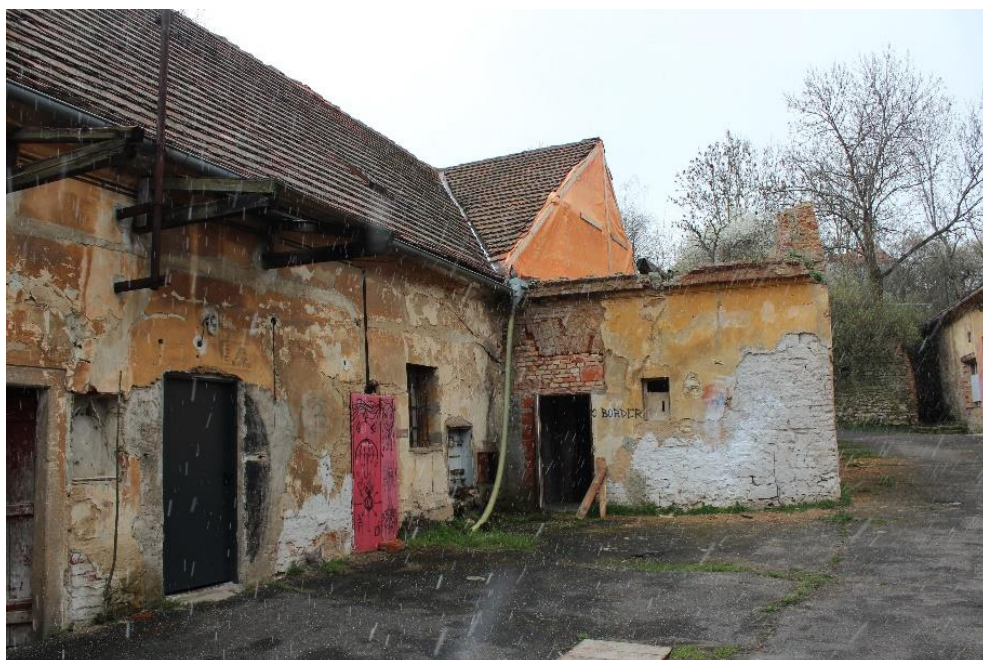
Obrázek 35 – Provizorní zakrytí krovu
