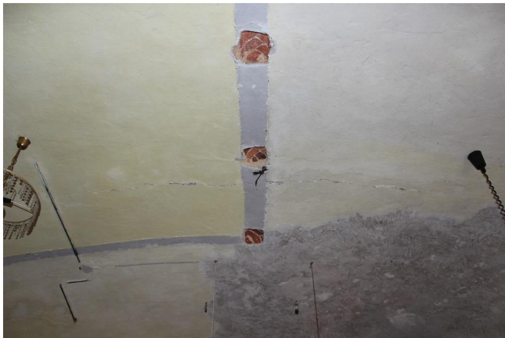
Obrázek 32 – Trhлина ze spodní strany
