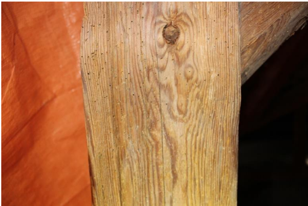
Obrázek 38 – Prvek napadený červotočem
