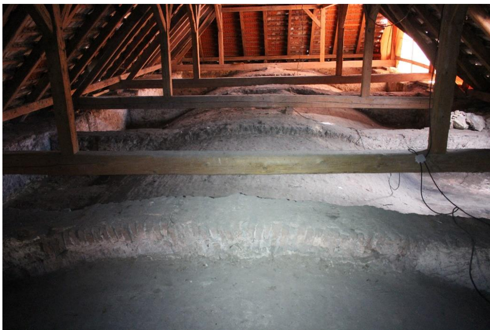
Obrázek 19 – Valená klenba z horní strany
