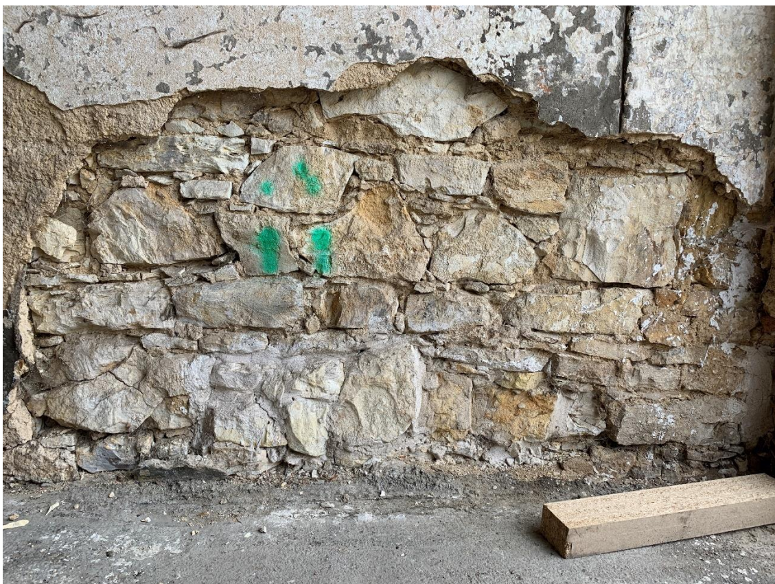
Obrázek 15 – Detail na zdící prvky obvodového zdiva
