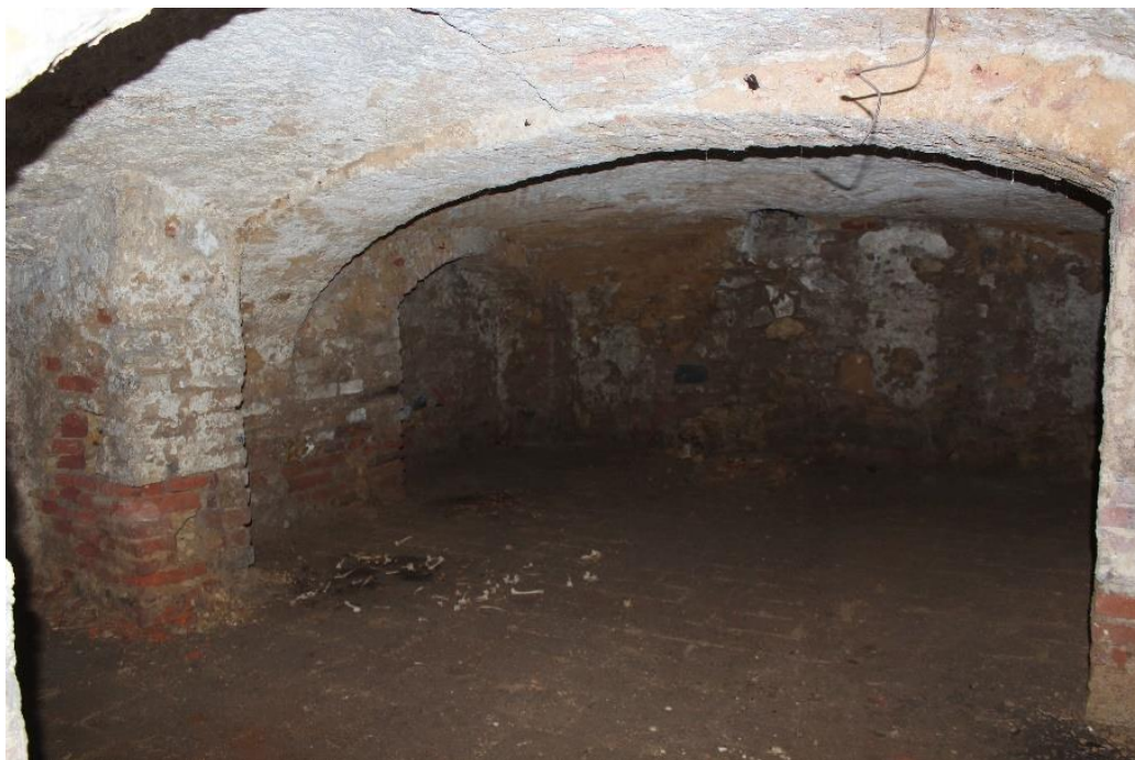
Obrázek 12 – Podsklepená část objektu
