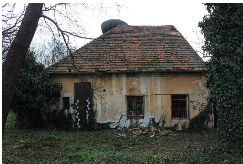
Obrázek 10 – Pohled na budovu B (jižní strana)
