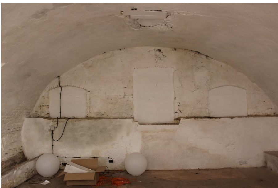
Obrázek 18 -Valená klenba opřená do zdiva
