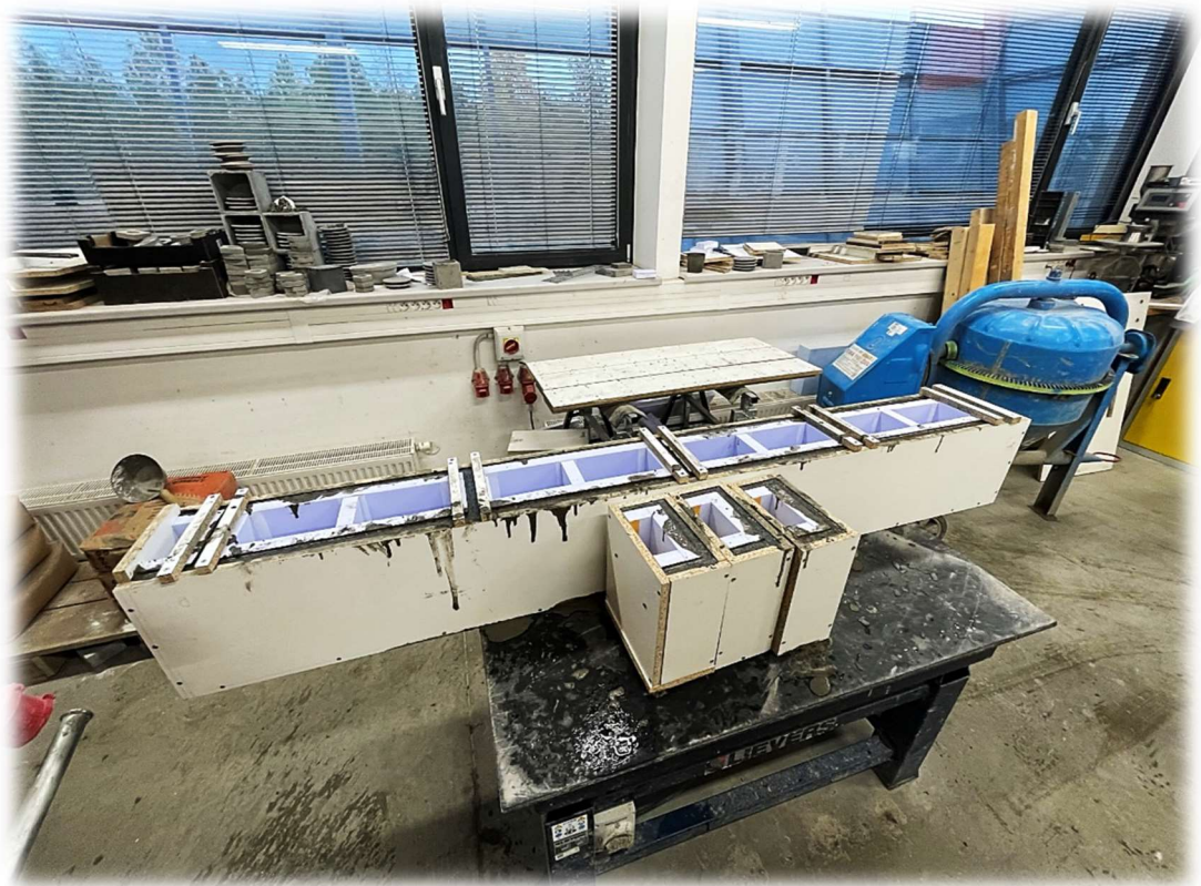
Obrázek 141 – Druhá betonáž základního a koncových dílců prototypu
