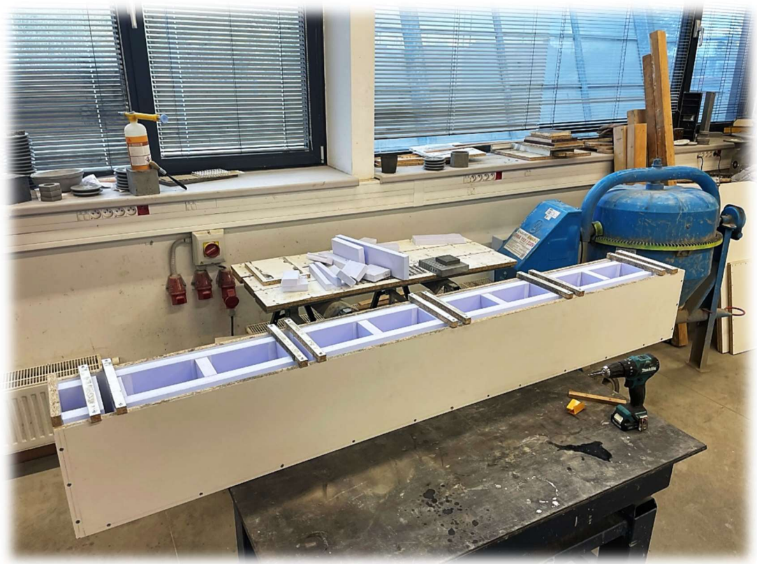
Obrázek 140 – Příprava formy pro druhou betonáž základního dílce prototypu
