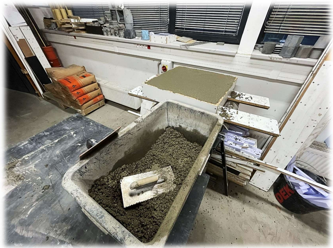
Obrázek 154 – Betonáž první patky prototypu
