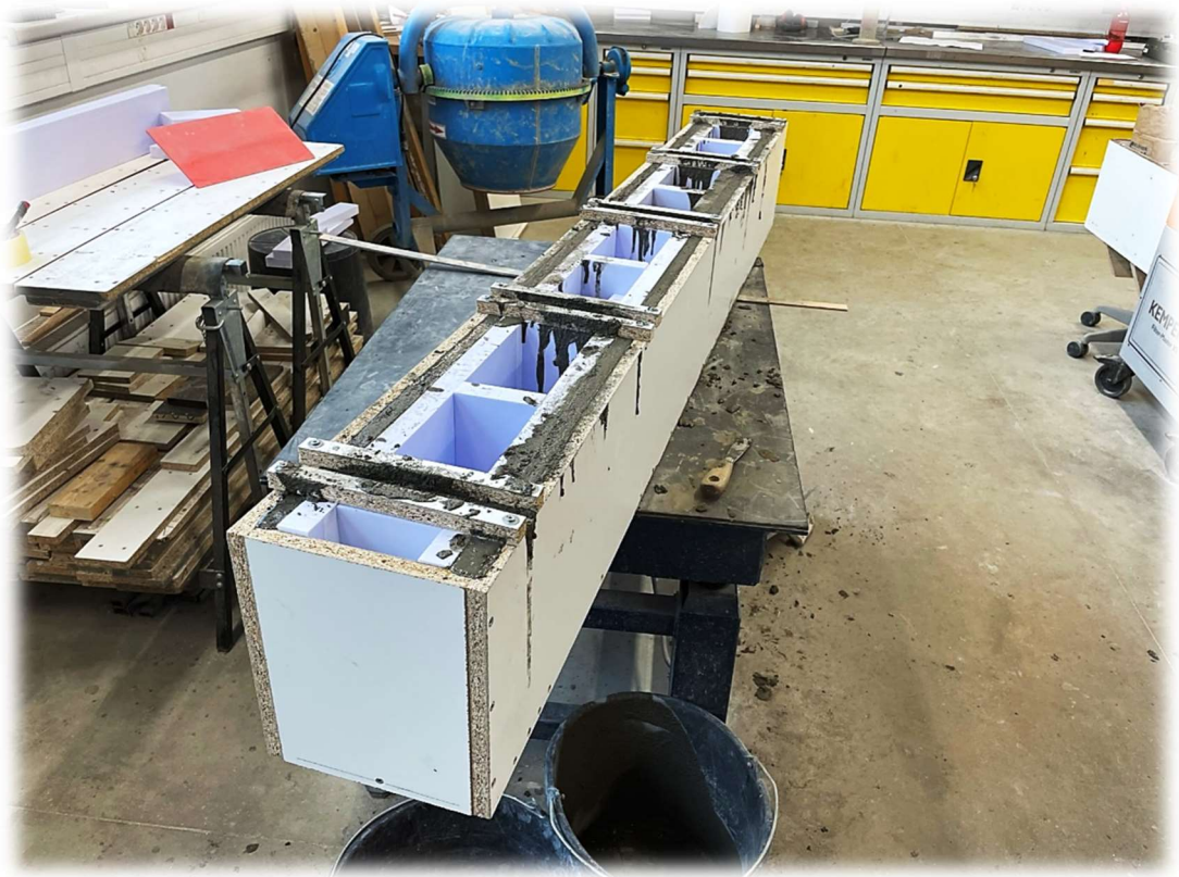
Obrázek 139 – První betonáž základního dílce prototypu
