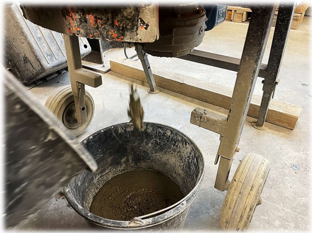
Obrázek 57 – Vypouštění hotové betonové směsi
