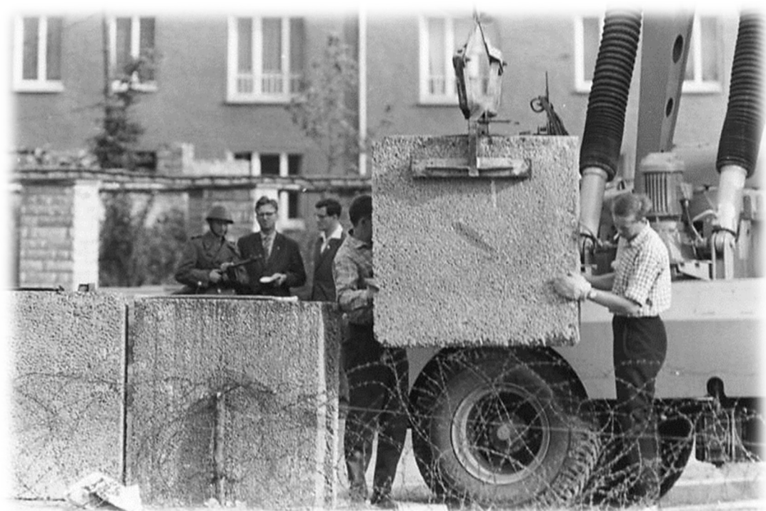
Obrázek 2 – Historická fotografie z usazování betonových dílců Berlínské zdi [3]
