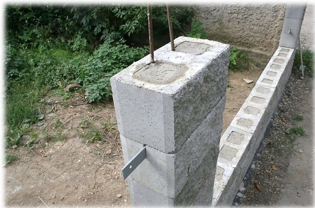
Obrázek 9 – Fotografie zděného plotu z betonových tvárnic v procesu realizace [10]
