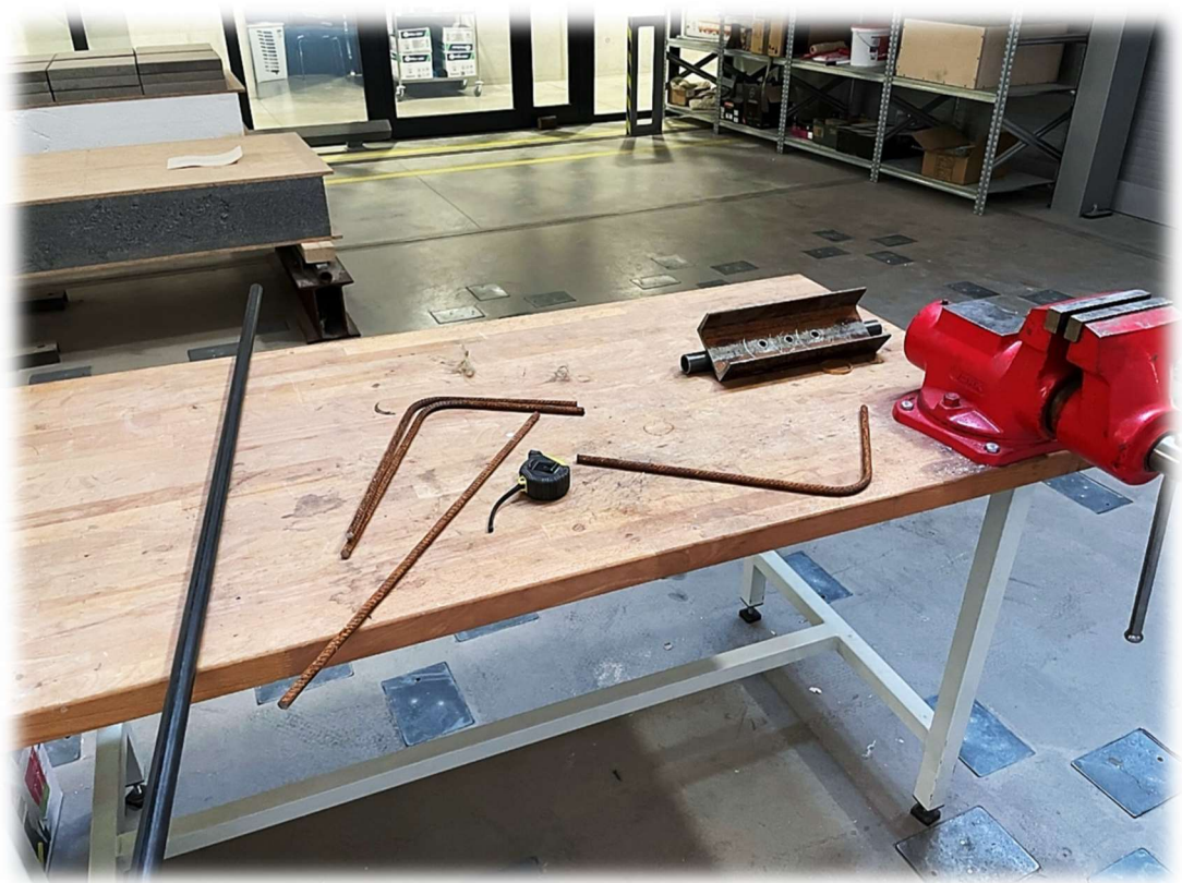
Obrázek 150 – Ohýbání startovací výztuže
