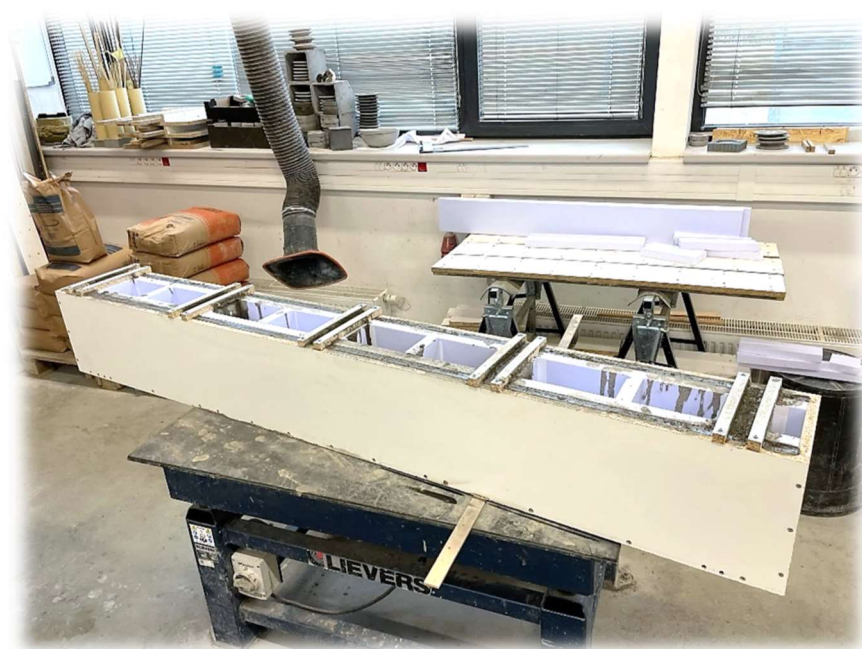
Obrázek 138 – První betonáž základního dílce prototypu
