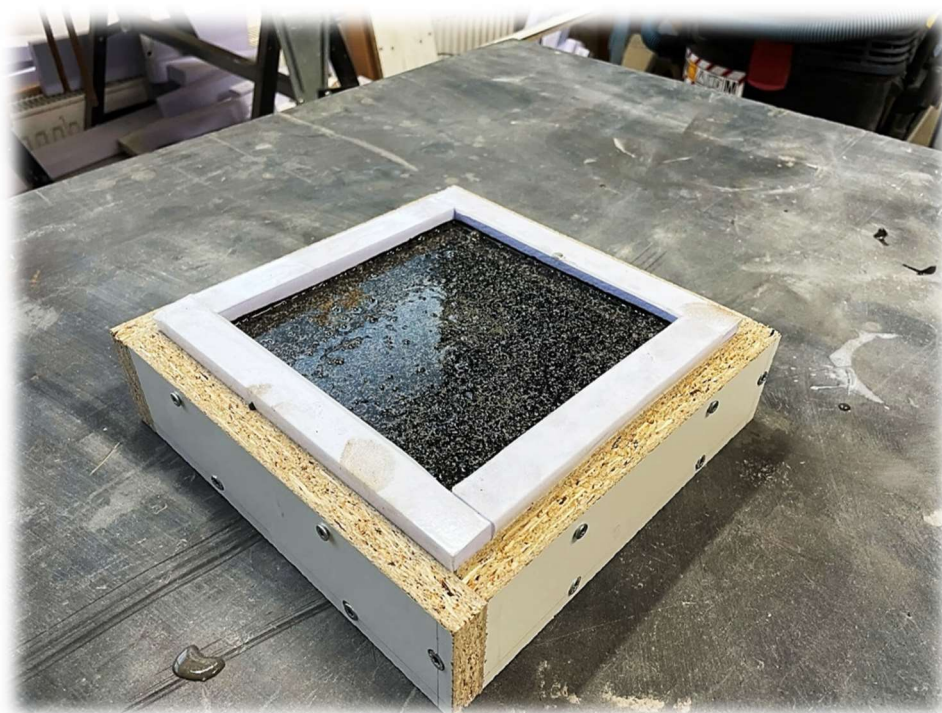
Obrázek 146 – Betonáž stříšky prototypu
