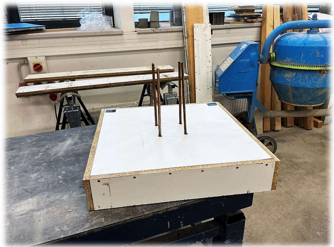
Obrázek 159 – Pohled na formu patky prototypu
