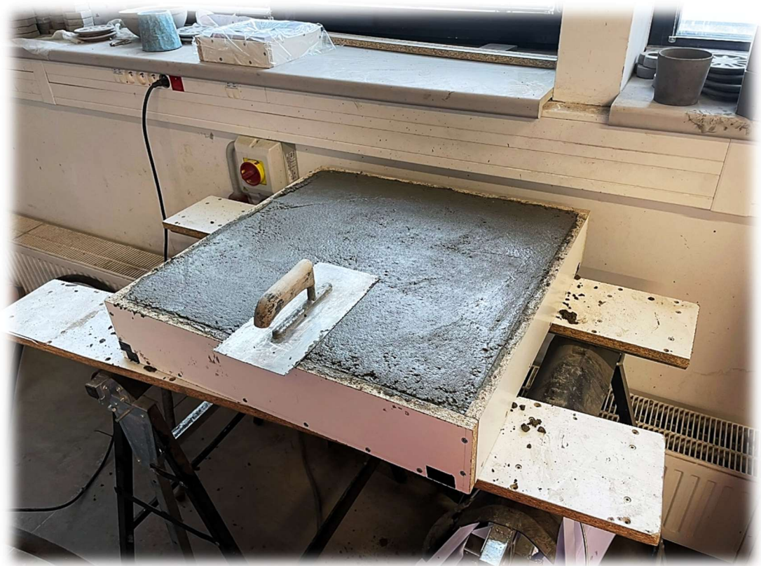
Obrázek 157 – Zhutněný beton patky prototypu pomocí ponorného vibrátoru
