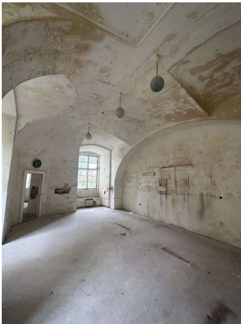
Obrázek 13- Strop v prvním nadzemním podlaží
