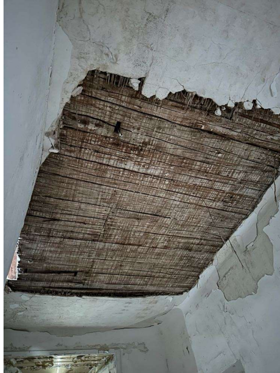
Obrázek 18- Strop s prkenný poklopem a omítnutou rákosovou rohoží
