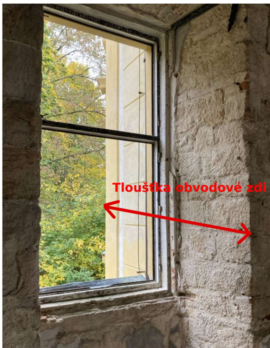
Obrázek 12- Obvodová zeď severního křídla
