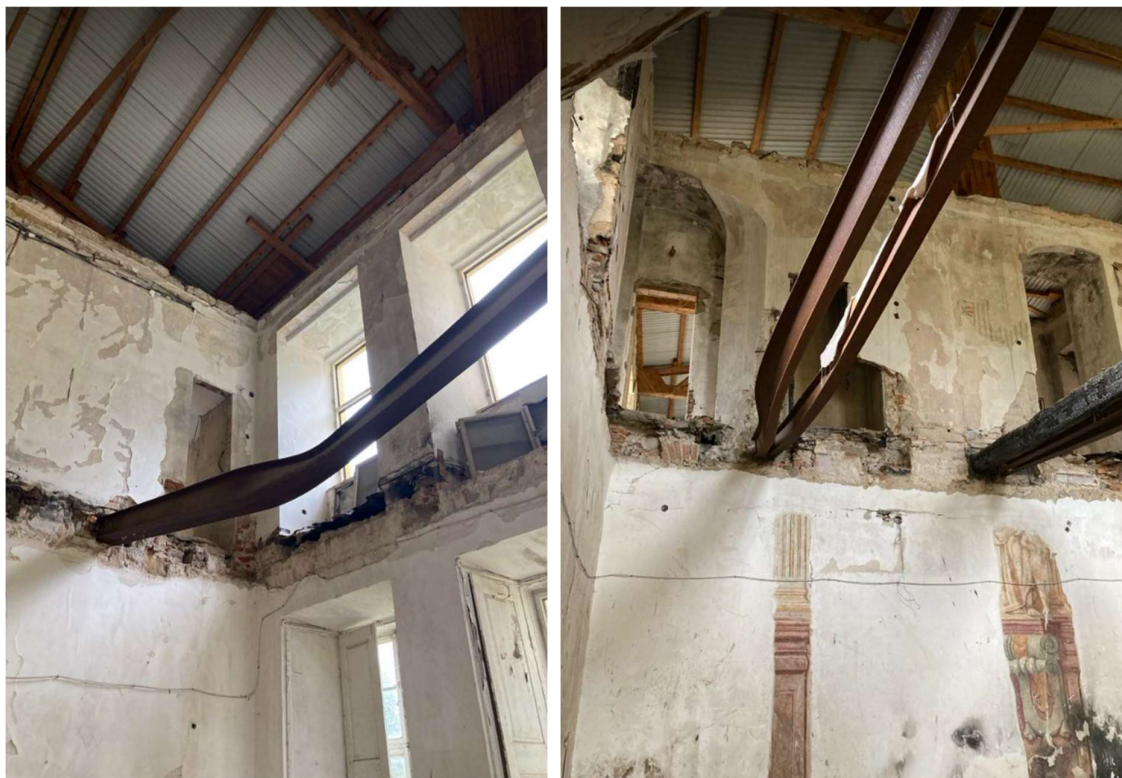
Obrázek 39- Zohýbané I nosníky stropní konstrukce
