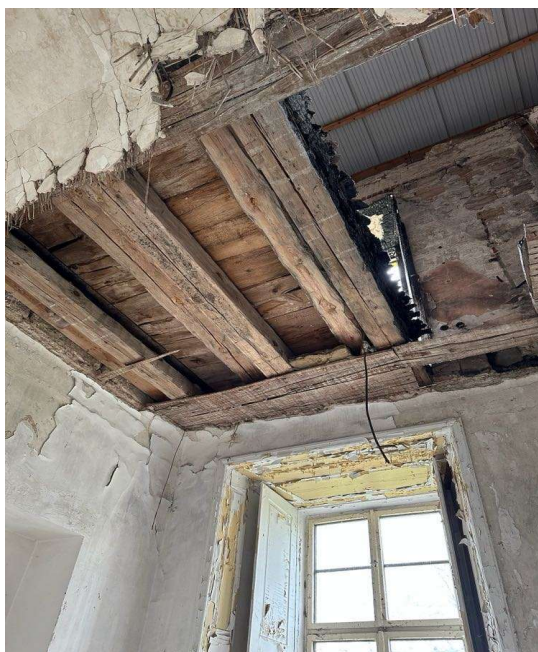
Obrázek 15- Dřevěný trámový strop
