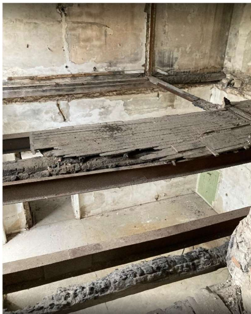
Obrázek 21- Vyztužení stropu ocelovými traverzami
