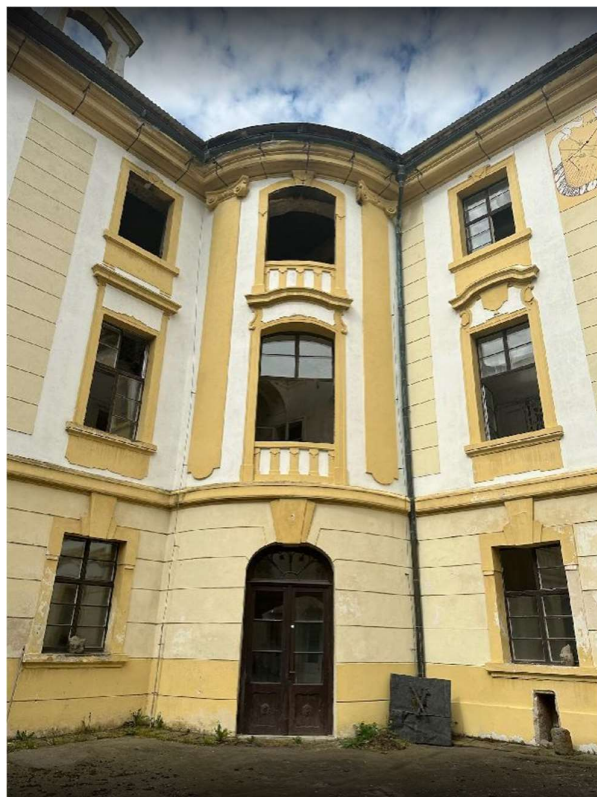
Obrázek 28- Zaoblené nadpraží nárožní jihovýchodní věžice z nádvoří
