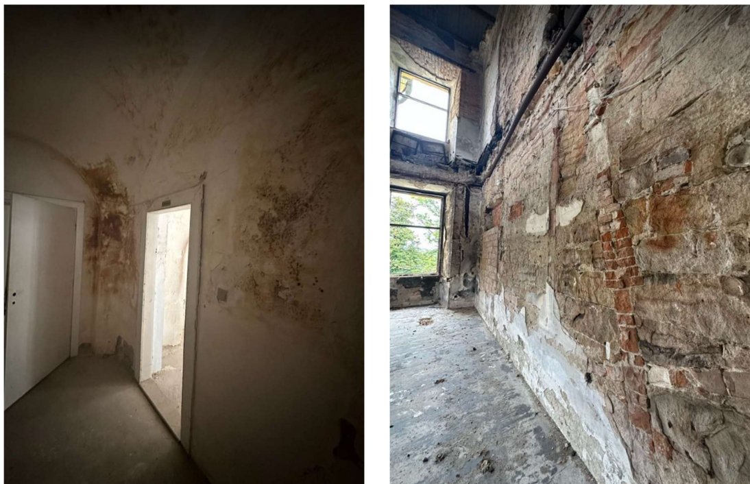
Obrázek 54- Mapovité obrazce (vlevo) a odpadnutí celé omítky (vpravo)
