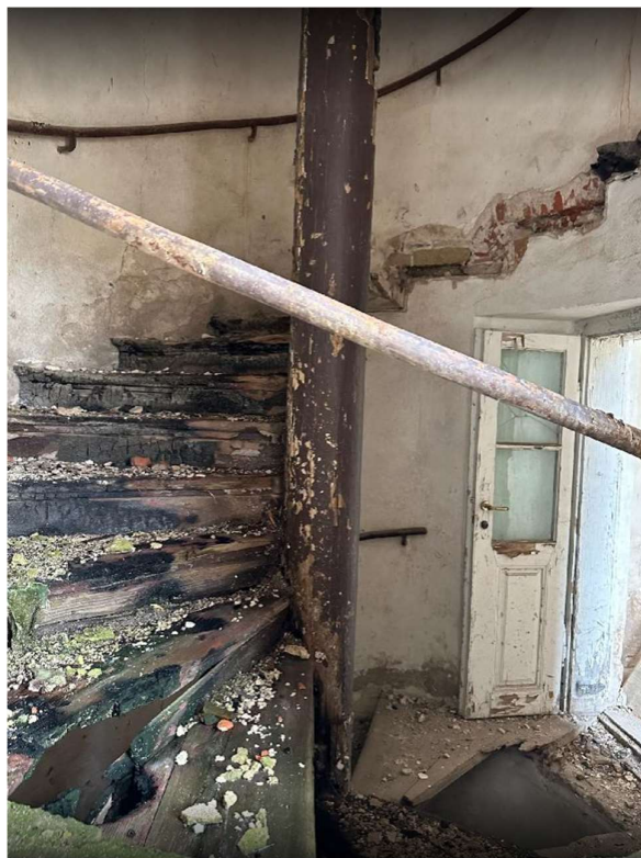
Obrázek 26- Dřevěné, vřetenové, točité schodiště v jihozápadní části
