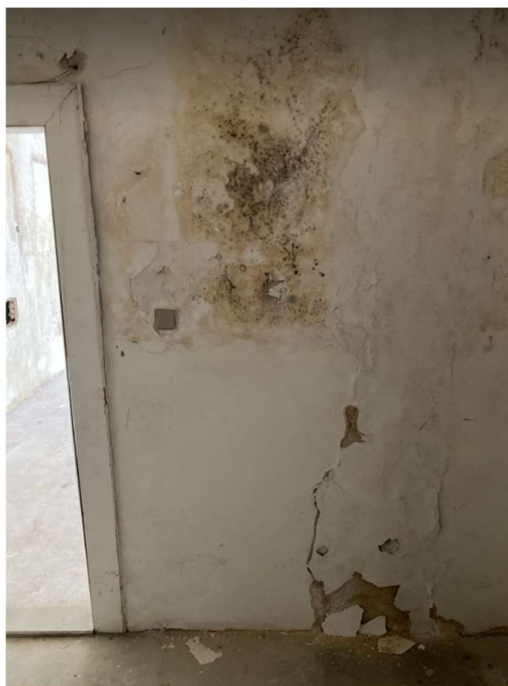
Obrázek 48- Porušení příčky, hniloba
