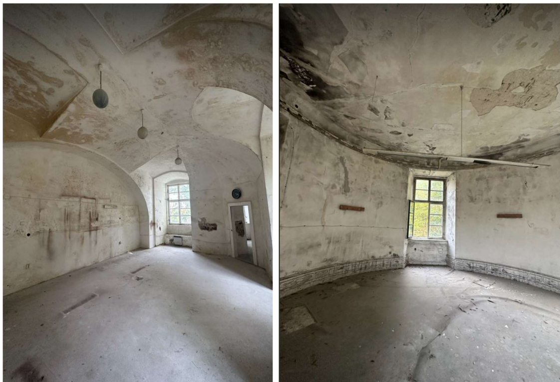
Obrázek 41- Mapovité obrazce stropní konstrukce INP
