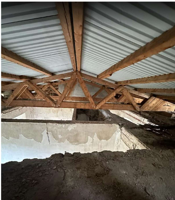
Obrázek 24- Provizorní zastřešení – sedlový vazník, krokve a plechová krytina
