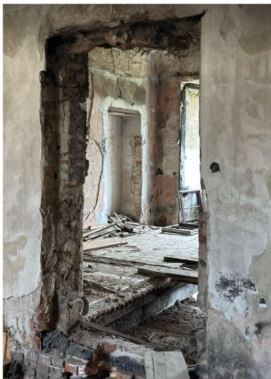
Obrázek 46- Chybějící dveře v nosné zdi (vlevo) a chybějící dveře v dělicí příčce (vpravo)
