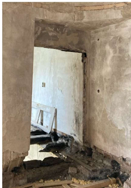
Obrázek 46- Chybějící dveře v nosné zdi (vlevo) a chybějící dveře v dělicí příčce (vpravo)
