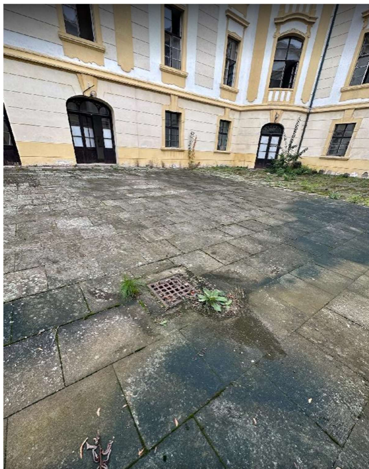
Obrázek 31- Kamenná dlažba v nádvoří
