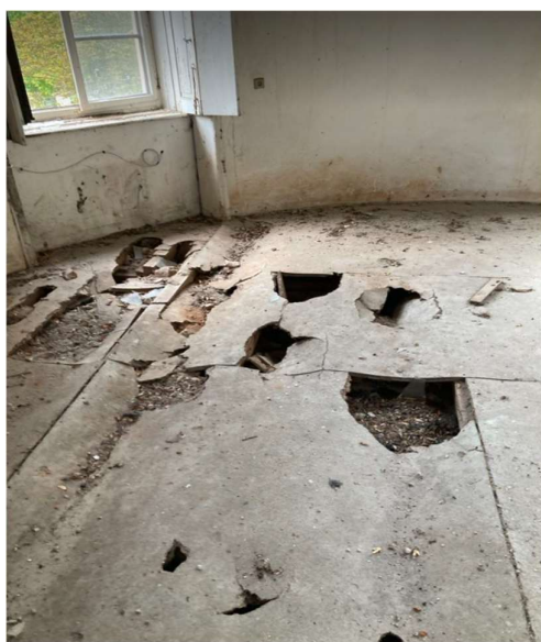
Obrázek 50- Porucha nášlapné vrstvy podlahy (vlevo) a chybějící podlaha s nosnými trámy (vpravo)
