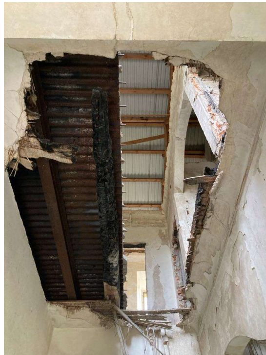
Obrázek 19- Strop v místě rekonstrukce s traverzou a trapézovým plechem
