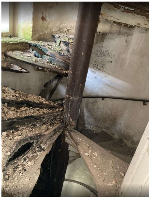
Obrázek 25- Dřevěné, vřetenové, točité schodiště v jihozápadní části
