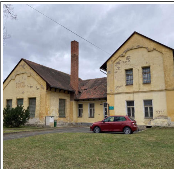
obr. /43/ Stávající komínové těleso
