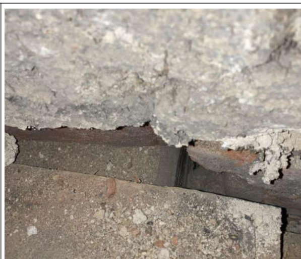
obr. /16/ Odhalení trámové výměny nad okenním otvorem a zhlaví trámu
