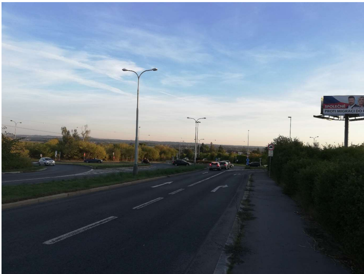
Obrázek 1 - Vzdálenější pohled na křižovatku z ulice Chilská (S)
