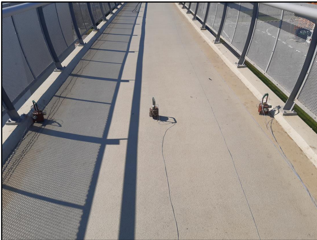
Obr. 26: Pohled proti směru staničení na snímače zrychlení umístěné ve sledovaném řezu.
