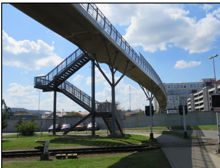
Obr. 14: Spodní pohled proti směru staničení na nosnou konstrukci lávky a na schodišťovou rampu.
