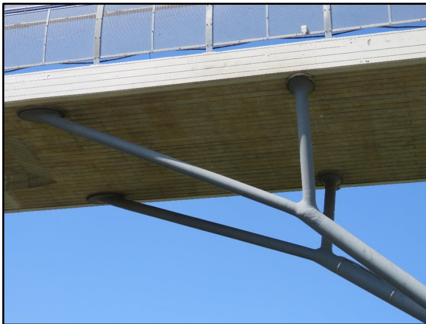
Obr. 18: Detailní pohled na spojení mostovky lávky a pilíře.
