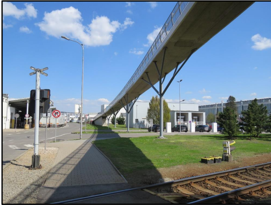
Obr. 19: Spodní pohled na nosnou konstrukci lávky a na opěru O110.
