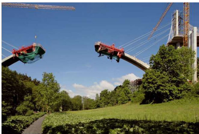
Obrázek 15: Letmá betonáž oblouku [25]
