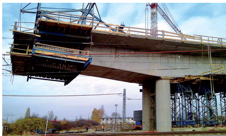
Obrázek 12: Provizorní podpory zárodku [26]
