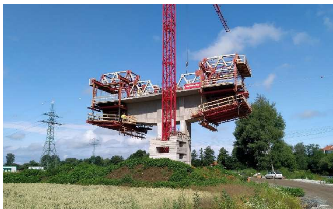
Obrázek 13: Betonážní vozíky a rámové stojky [27]
