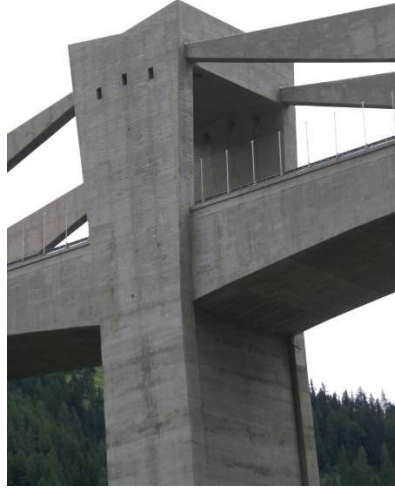
Obrázek 3: Detail provedení v oblasti podpor mostu Ganter [19]
